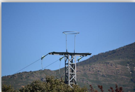
Fig12. Modificación en torre eléctrica en el CERl.
