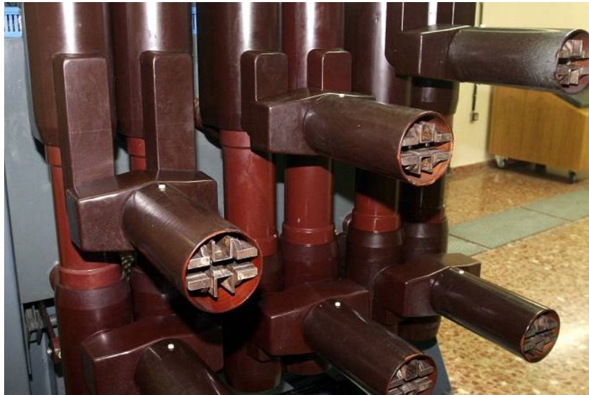
Interior de un interruptor de media tensión.
