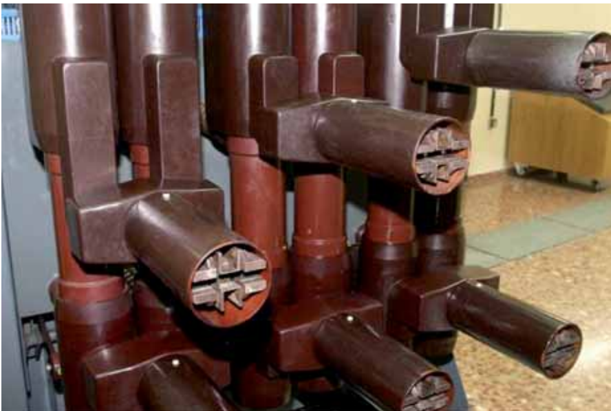
Interior d'un interruptor de mitjana tensió
