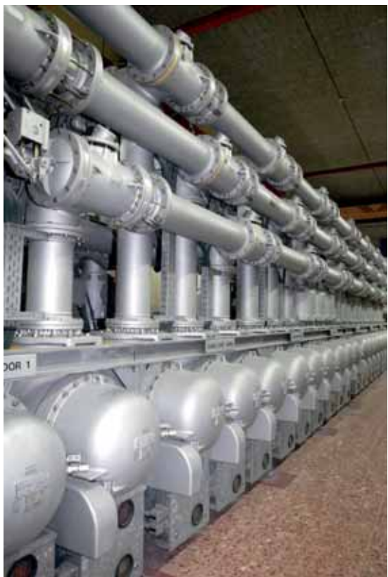
Sala GIS (sala d'interruptors d'alta tensió).
