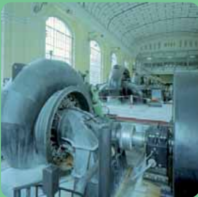
Fotografia i esquema 2.4. Fotografia d'una turbina Francis.
