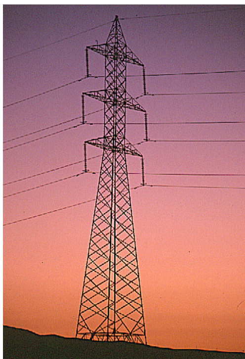
Cableado de las torres. En él se ve el cable neutro.
