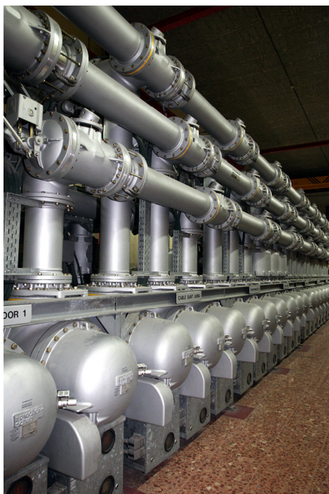
Fotografía 2.1. Parte de una subestación. (sala de interruptores de alta tensión)
