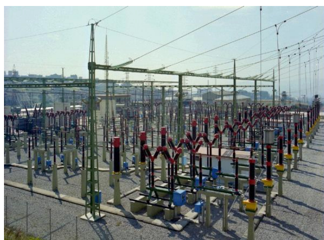
Fotografía 2.2. Ejemplo de una subestación aérea.
