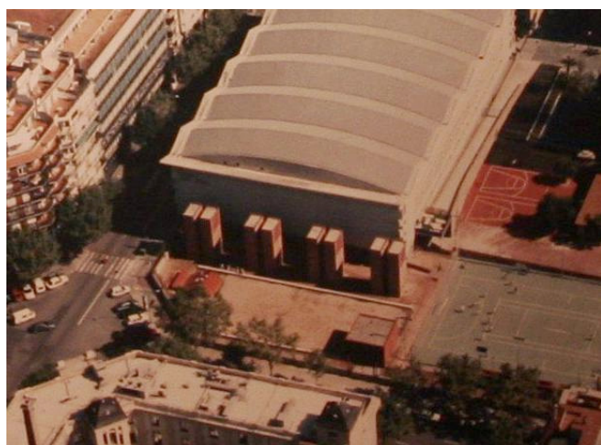
Fotografía 2.3. Ejemplo de una subestación enteramente bajo tierra. Se ven las columnas de refrigeración.
