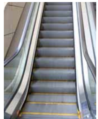
Escales mecàniques que funcionen amb sensors de presència.
