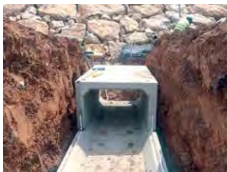
▼ UPH Noroeste. Detalle de la escollera, del canal de evacuación de aljibes y del revestimiento final de aljibes con mampostería.
