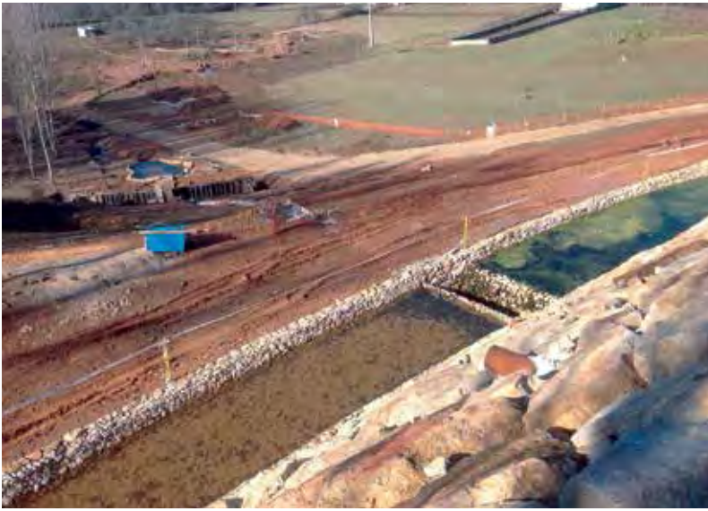
▲ UPH Noroeste. Vista general de las obras.
