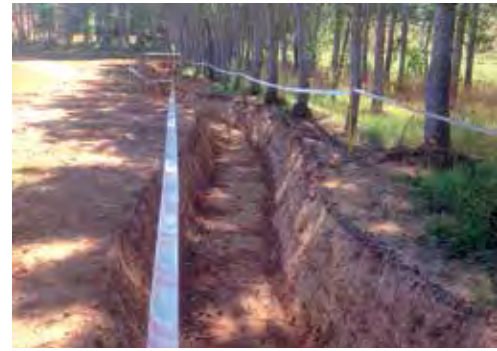
▲ UPH Noroeste. Detalle del vaciado en formación de río.
