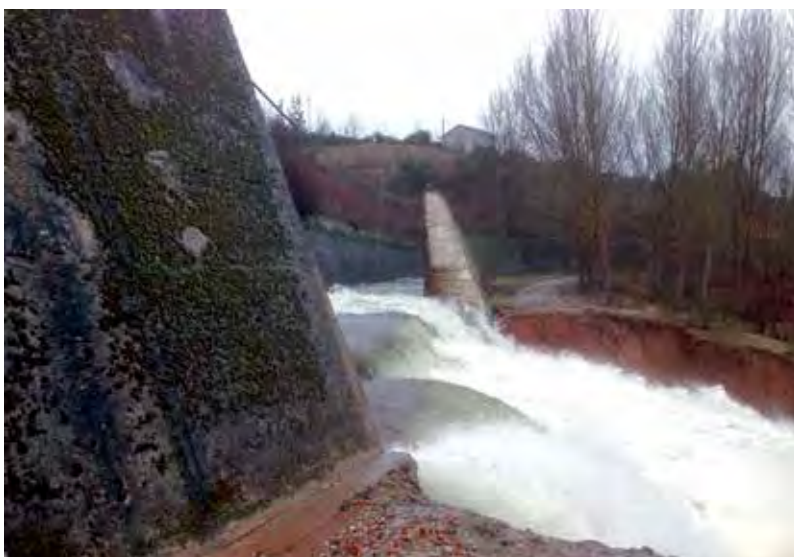
▲ UPH Noroeste. Vista de la rotura en el Canal de Santa Marina y de los terrenos anegados por la inundación.
