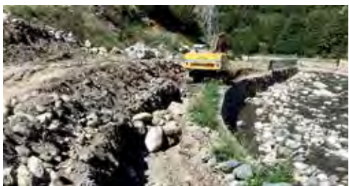
◀ UPH Ebro Pirineos. Reposición del Camino Real en el margen izquierdo del río Garona en Era Bordeta (Vilamós).
