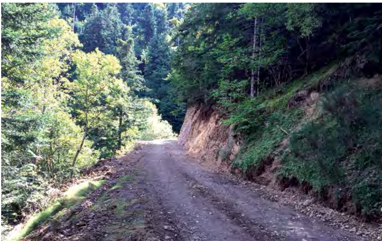
UPH Ebro Pirineos. Restauración de la pista Margalida en Bossòst. Antes y después de la ejecución de la obra.
