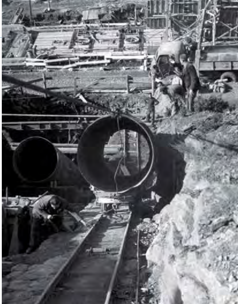
▲ Central hidroeléctrica de Vilaller. Montaje de la tubería forzada. Ficha número 52917 del Archivo Fotográfico Digital del Fondo Histórico de Endesa.
