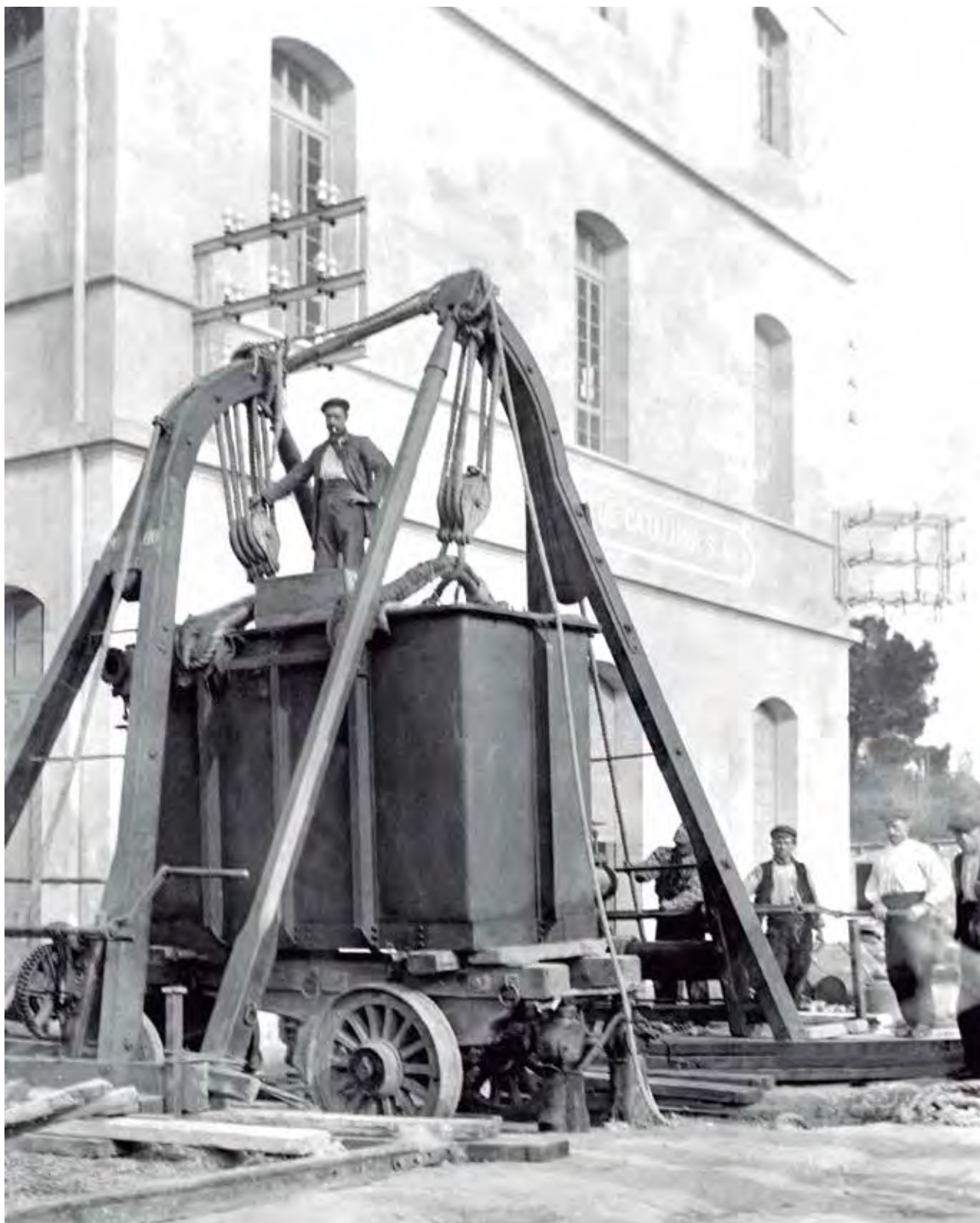
Tareas de descarga de un transformador en una subestación del Pirineo. Ficha número 40871 del Archivo Fotográfico Digital del Fondo Histórico de Endesa.
