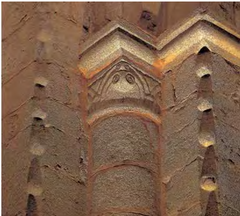
▼ La Seu d'Urgell. Detalle de la iluminación.
