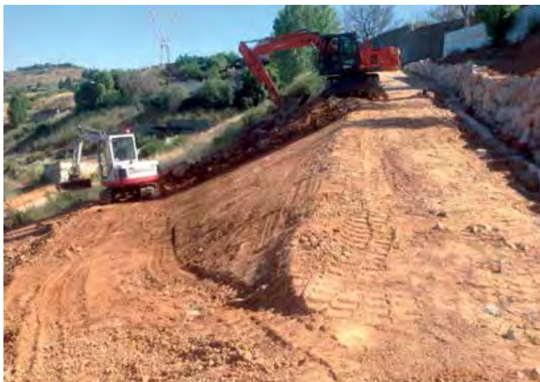
▲ UPH Noroeste. Ejecución de la senda peatonal.
