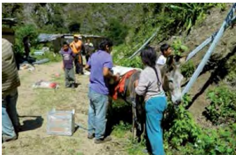
▼ Difícil traslado de material para las nuevas instalaciones en Perú.
