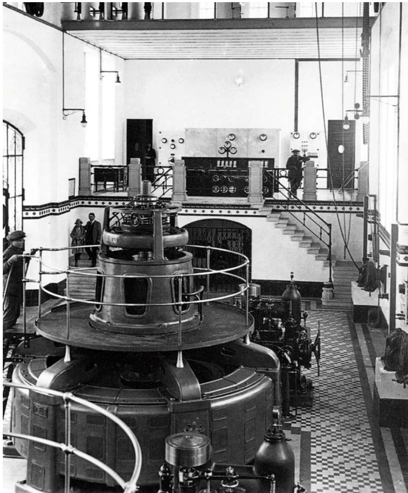
Interior de la central hidroeléctrica de Mengíbar, Jaén, hacia 1920. Foto Alfonso. Archivo: Compañía Sevillana de Electricidad
