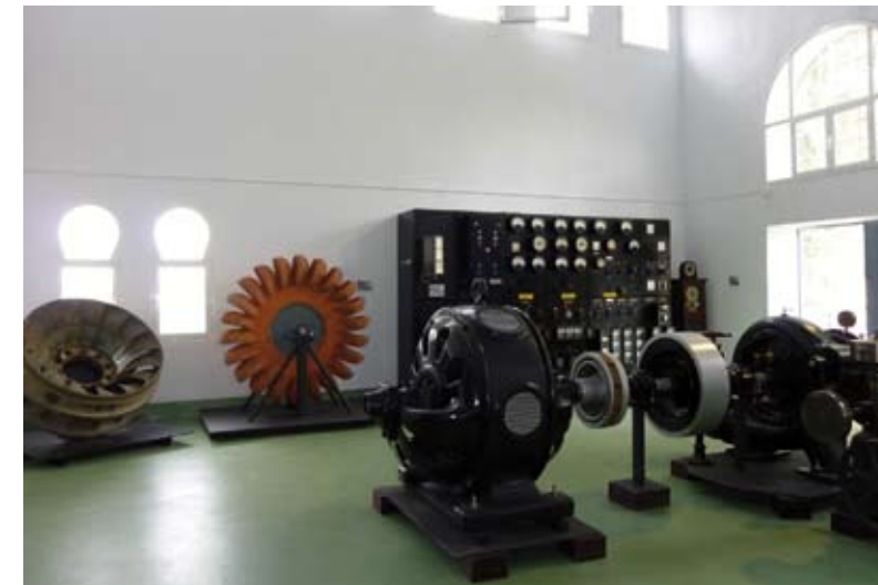
▲ C.H. El Carpio. Equipos tecnológicos trasladados a esta central desde la nave situada en Bollullos de la Mitación. (Sevilla)
