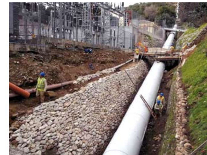
▶ CH. Buitreras. Demolición de antiguas construcciones y adecuación de las laderas de la tubería forzada
