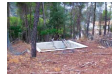
▲ C.H. Pintado. Retirada de restos y demolición e integración paisajística de la antigua piscina. Antes y después
