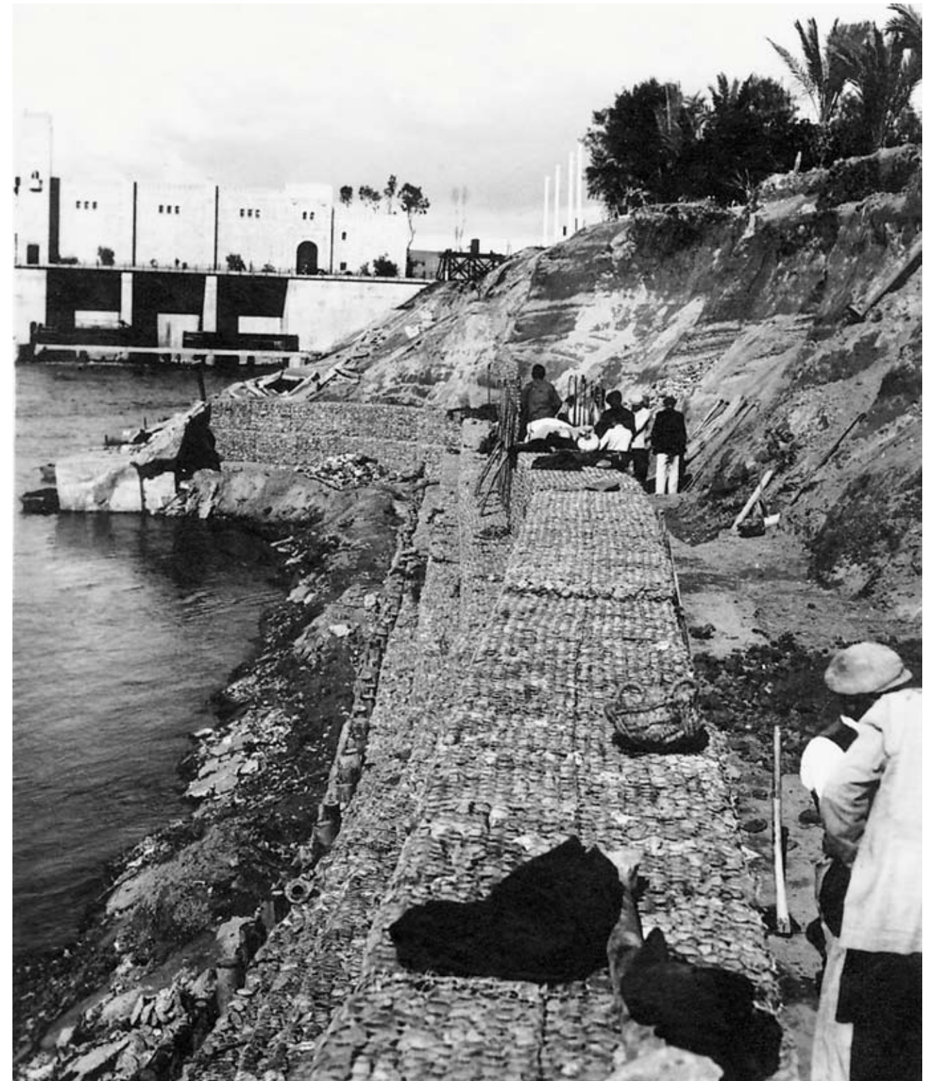
Construcción del dique para corrimiento de tierras. Central de Alcalá del Río, Sevilla. Año 1960. Ficha 53659 del Archivo Fotográfico Digital del Fondo Histórico de Endesa
