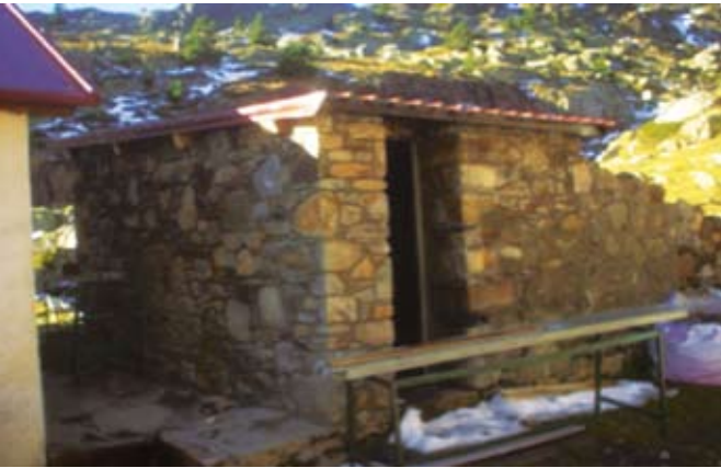
CH. Tavascán. Reconstrucción de la caseta colindante con el refugio Antes y después de la reconstrucción
