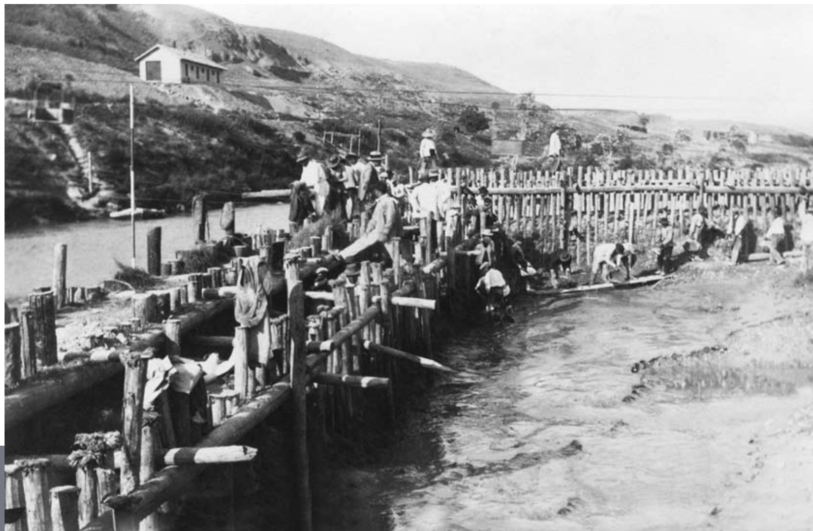
Trabajos de construcción de la presa de Mengibar en Jaén. Año 1915. Ficha 53663 del Archivo Fotográfico Digital del Fondo Histórico de Endesa
