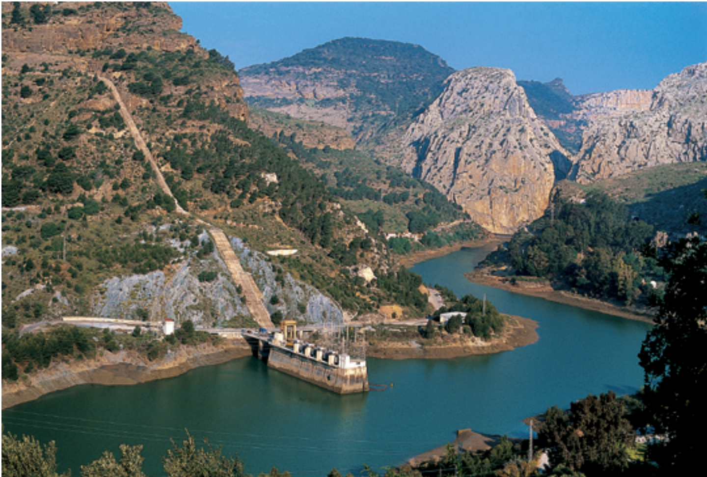
Central hidroeléctrica de bombeo Tajo de la Encantada, perteneciente a la Agrupación Antequera
