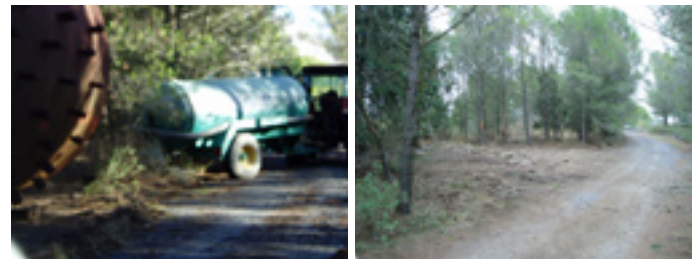
Retirada de los restos de tubería forzada
