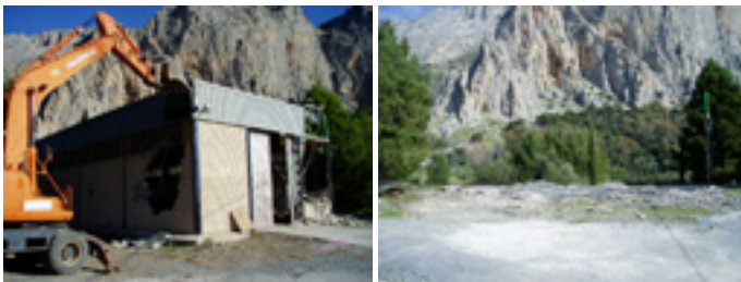
Desmantelamiento y demolición del antiguo almacén
