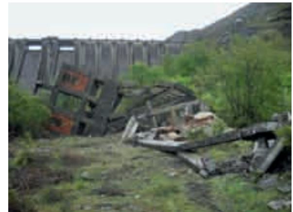
Presa San Sebastián sobre el río Bibey, en Zamora Demolición de viejos edificios de fábrica
