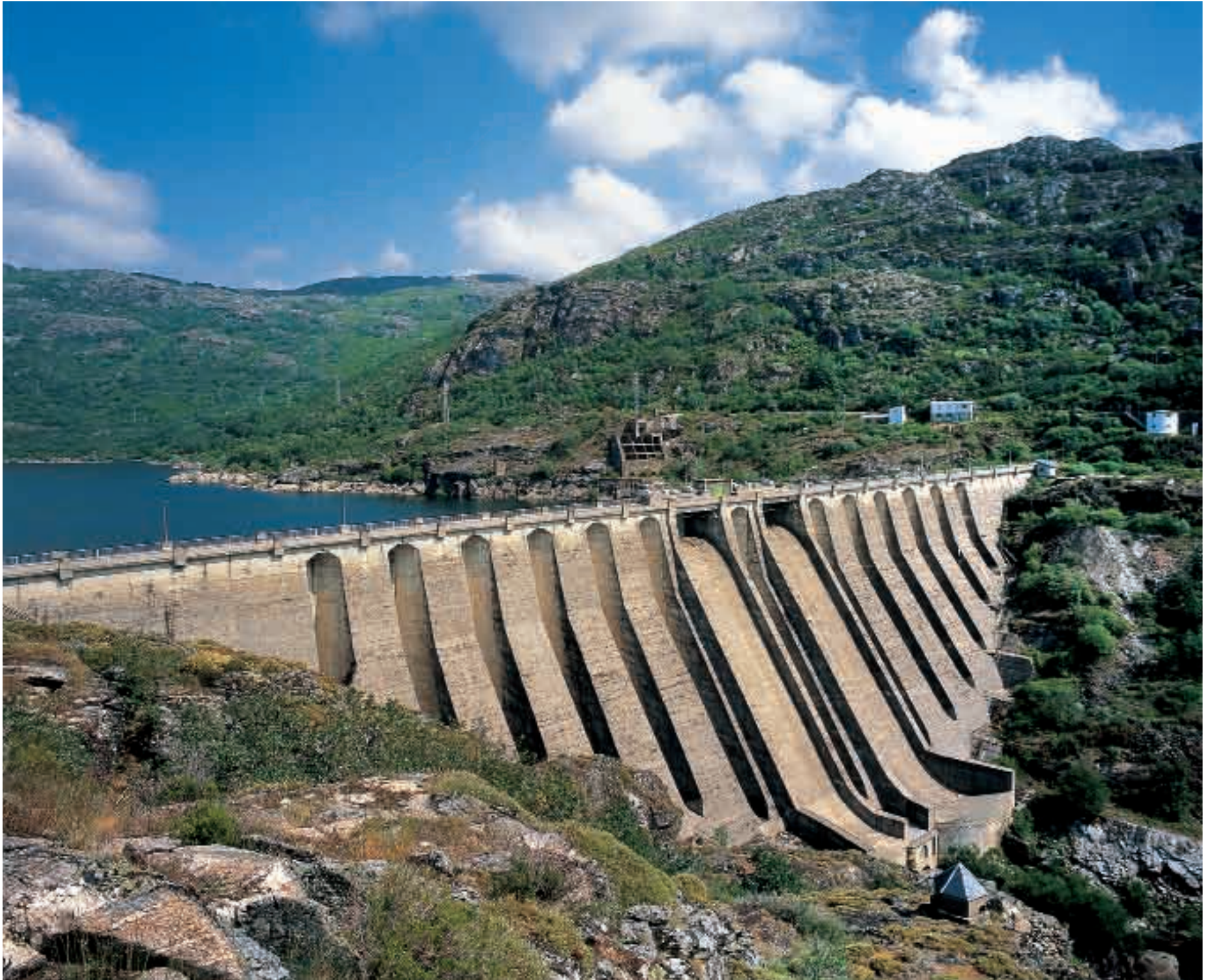
Adecuación paisajística de la presa San Sebastián, del sistema Bibey
