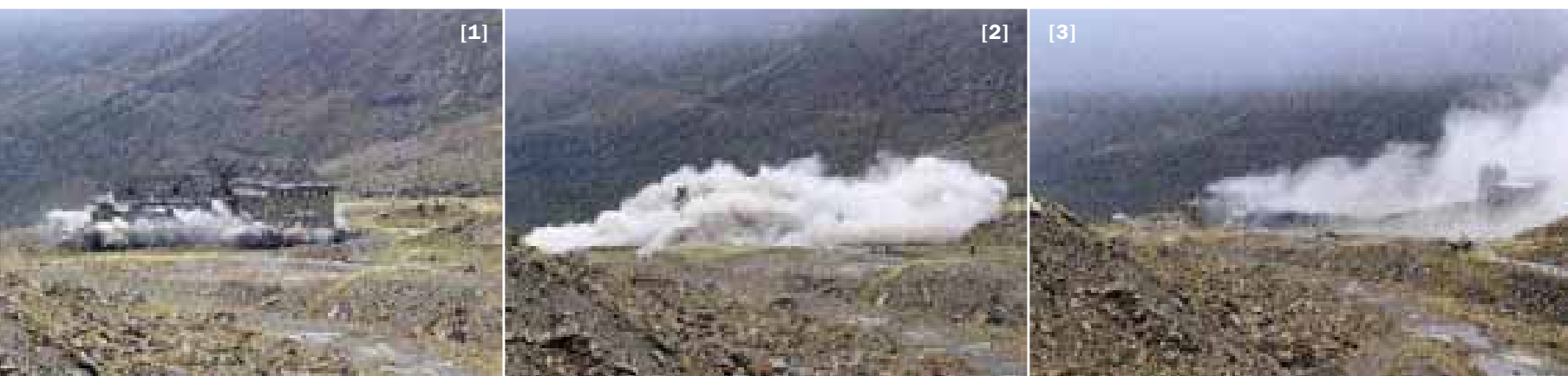
[1], [2] y [3] Fases de la voladura del albergue de los trabajadores de la presa Ip Canfranc (Huesca)
