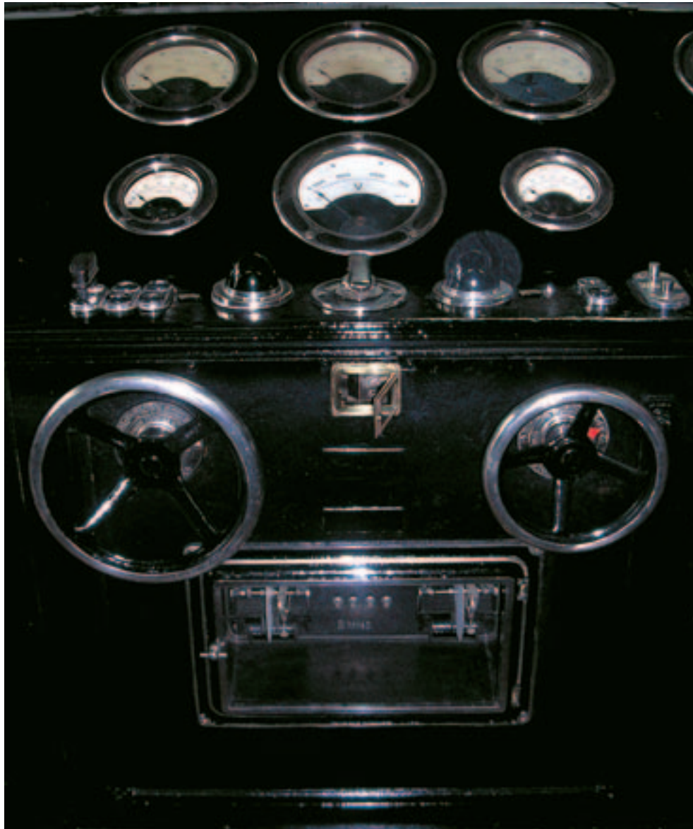
CUADRO DE MANDOS DEL SEGUNDO CUARTO DEL SIGLO XX DE LA CENTRAL LLEIDA
