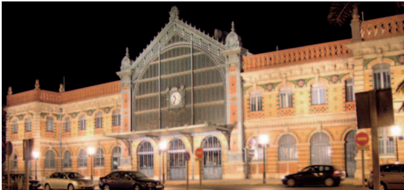
ANTIGUA ESTACIÓN DE FERROCARRIL DE ALMERÍA
