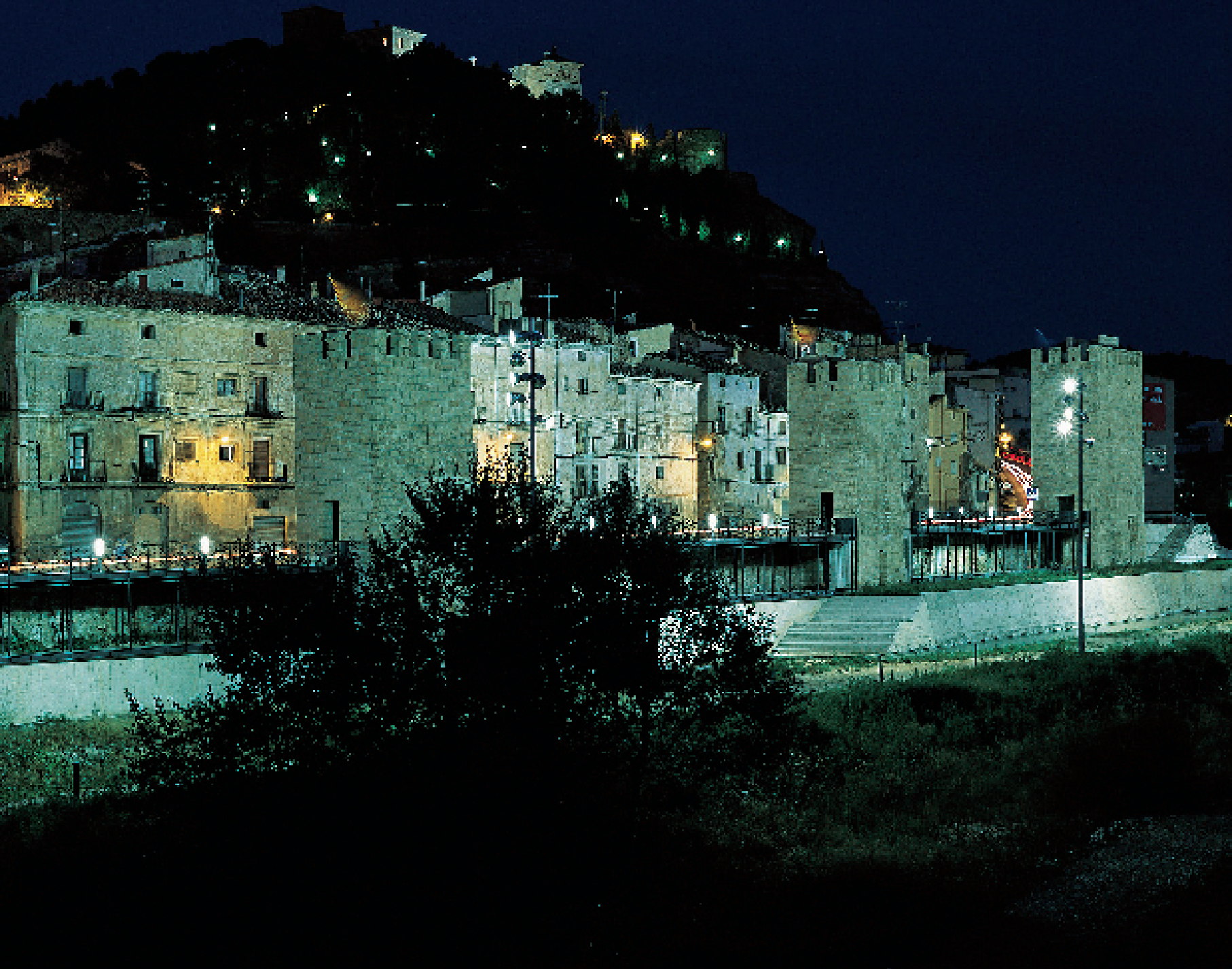
Muro de Santiago. Alcañiz (Teruel)
