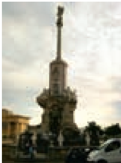
Acuerdo con el Ayuntamiento de Córdoba, para la iluminación de dos esculturas colocadas en parques de la ciudad y la renovación de los apliques de iluminación de la sala y patio de butacas del Gran Teatro de Córdoba.
