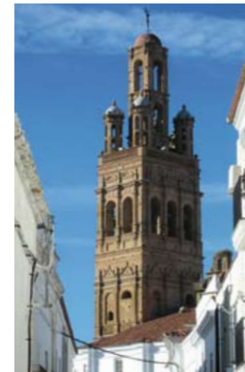
Torre de la Iglesia Mayor de Ntra. Sra. de la Granada y arcos de la fachada colindante Llerena (Badajoz).
