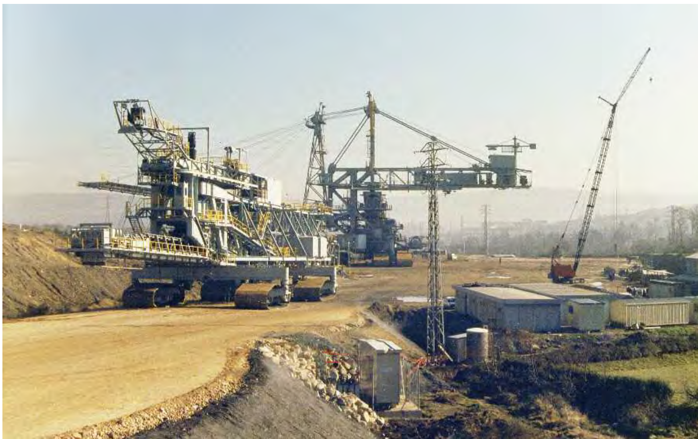
Plaza de montaje de la 1ª apiladora
