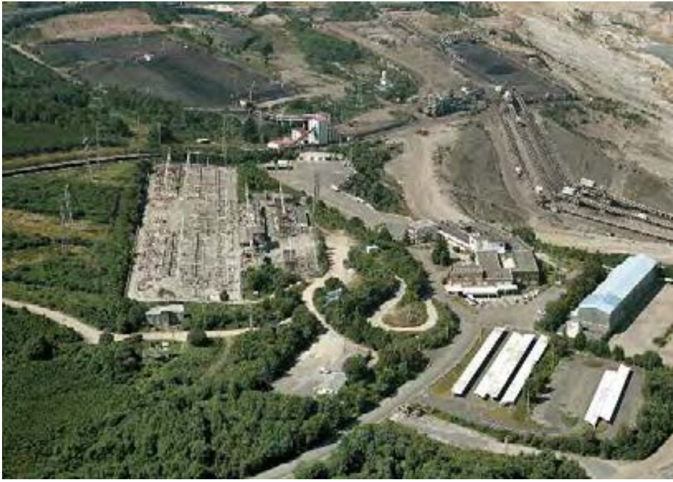
Vista de la subestación, 2007
