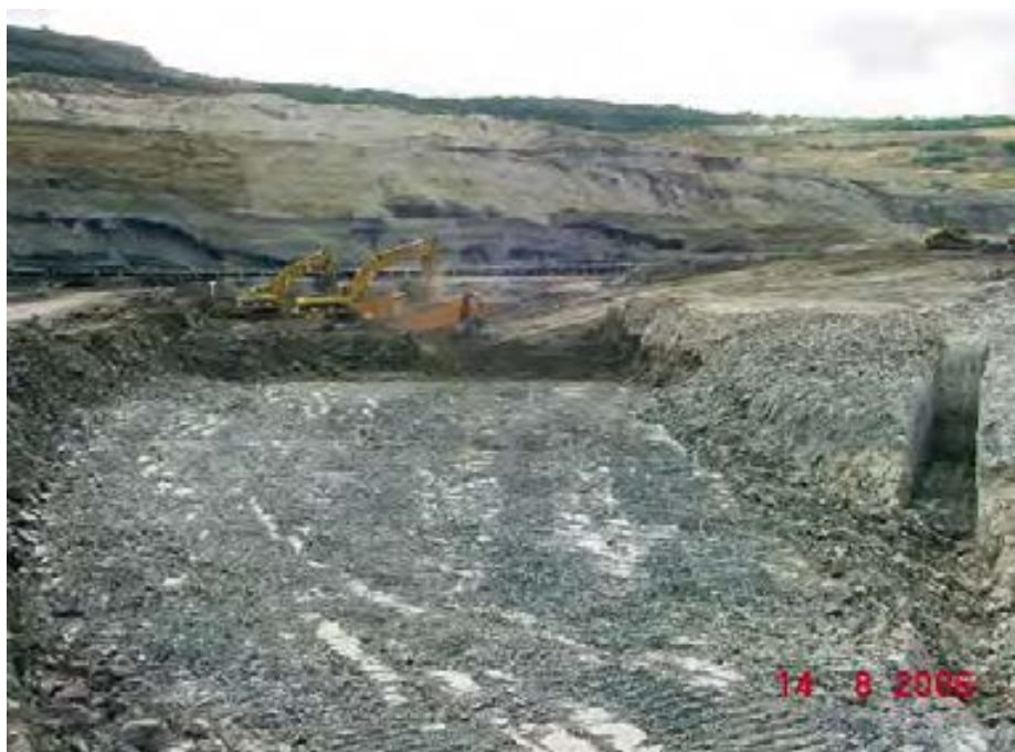
Excavadoras convencionales limpiando el nivel productivo, 2006
