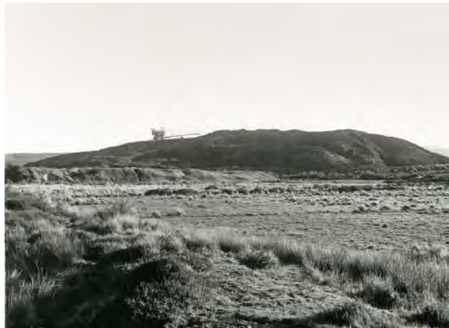
Vista de la escombrera exterior
