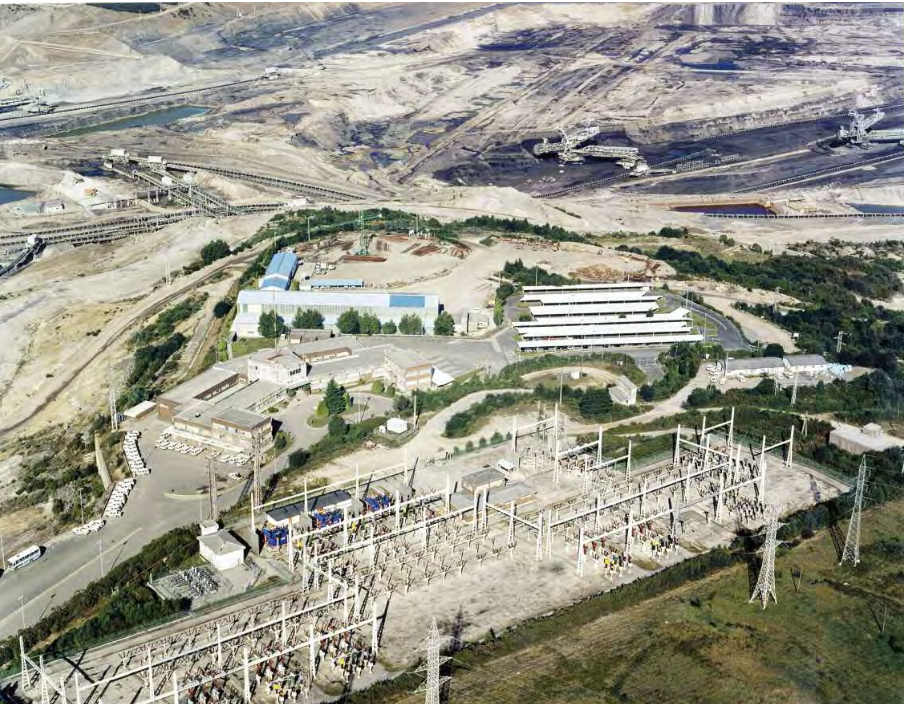
Vista de la subestación, 2004
