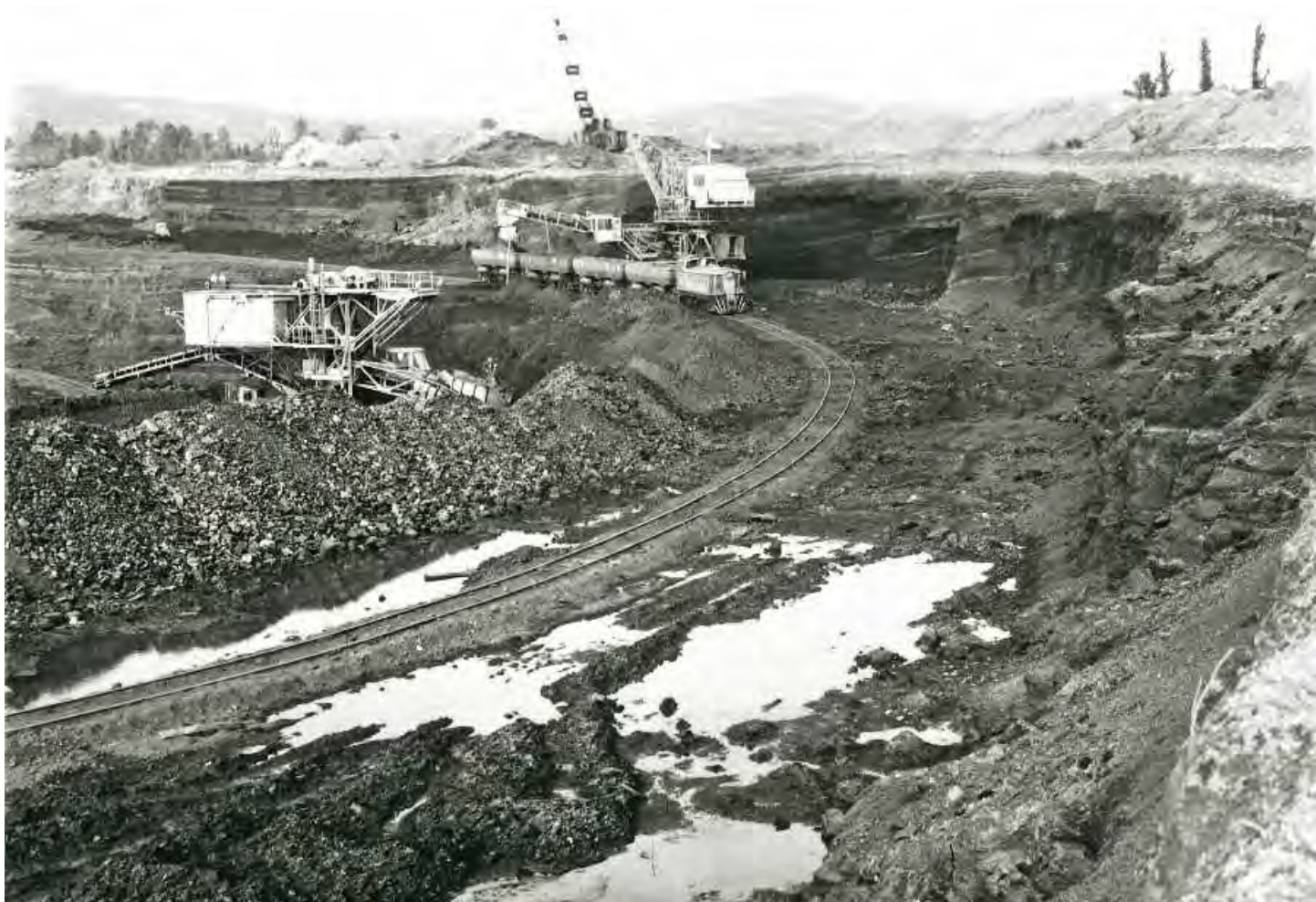
Año 1965. Primeras excavadoras de rodete R1 y R2
