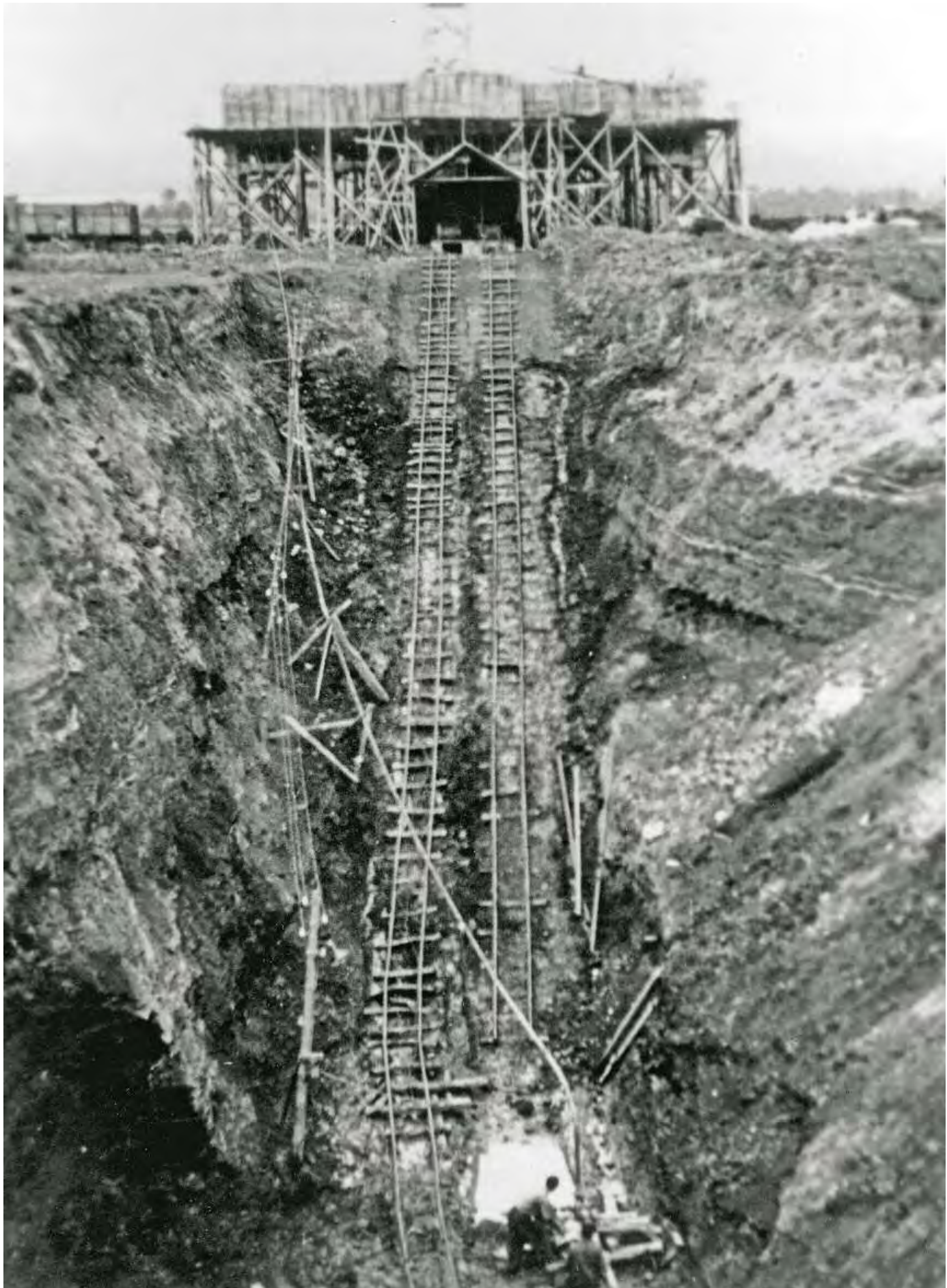
Foto de la que quizá fue la primera apertura de la mina de As Pontes, año 1946. Dos operarios (abajo) resolviendo problemas de bombeo
