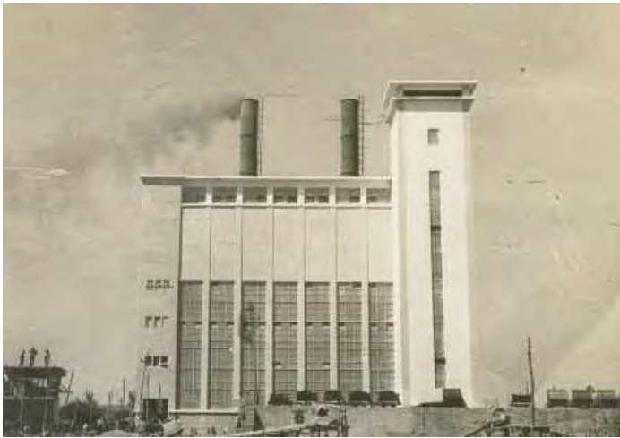
Año 1951. Central térmica y conjunto Areosa
