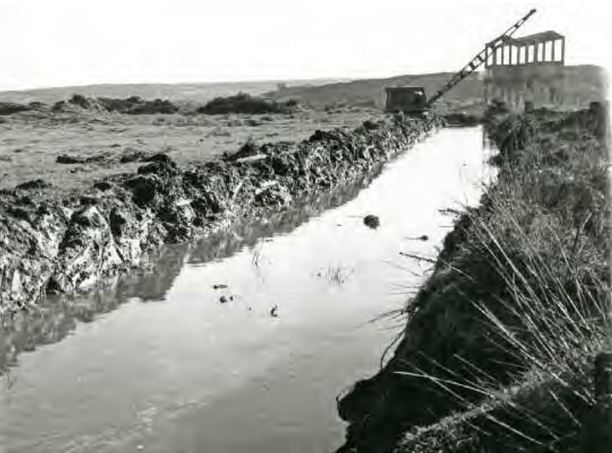
Dragalina construyendo un canal de protección
