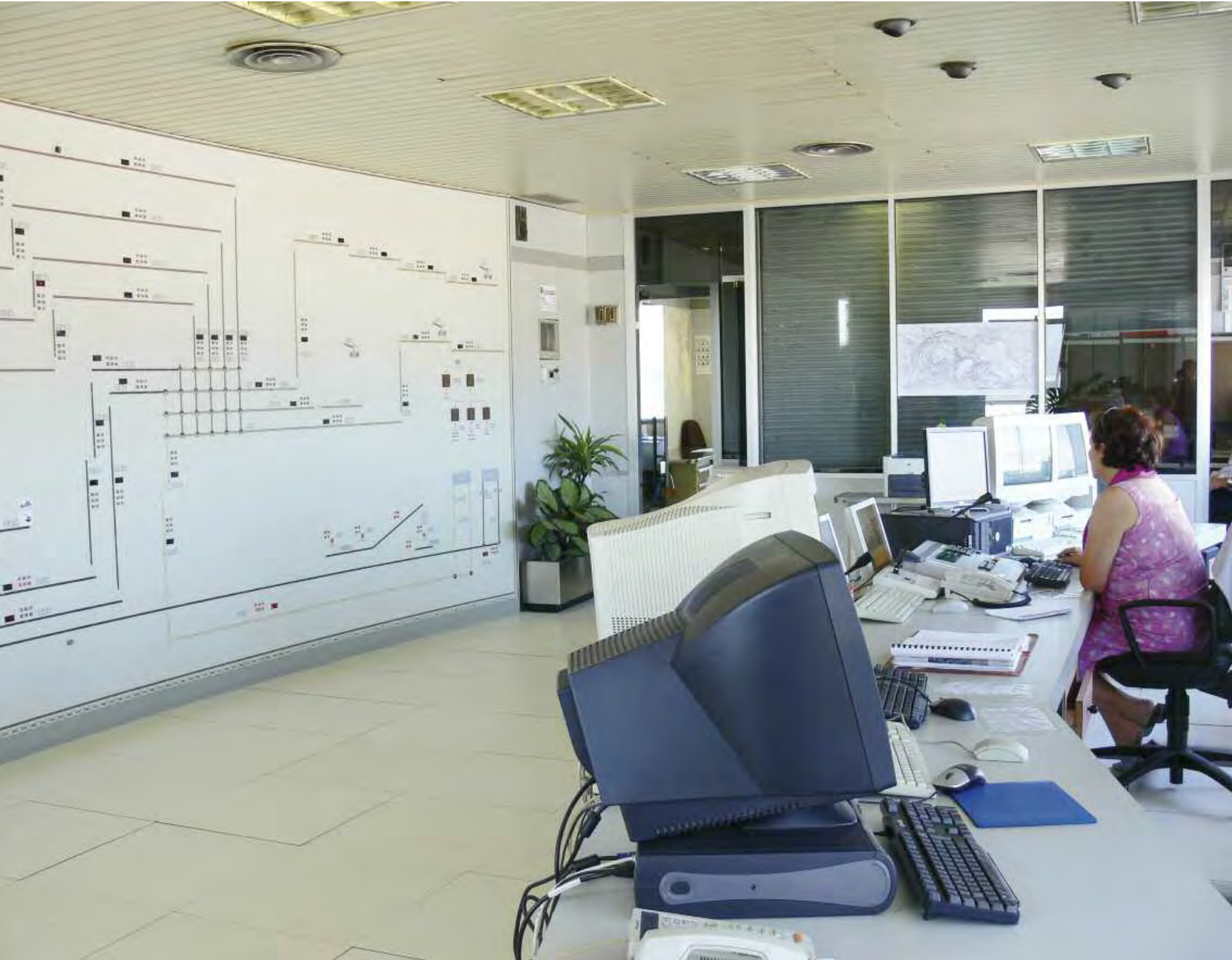
Sala de Control, 2007
