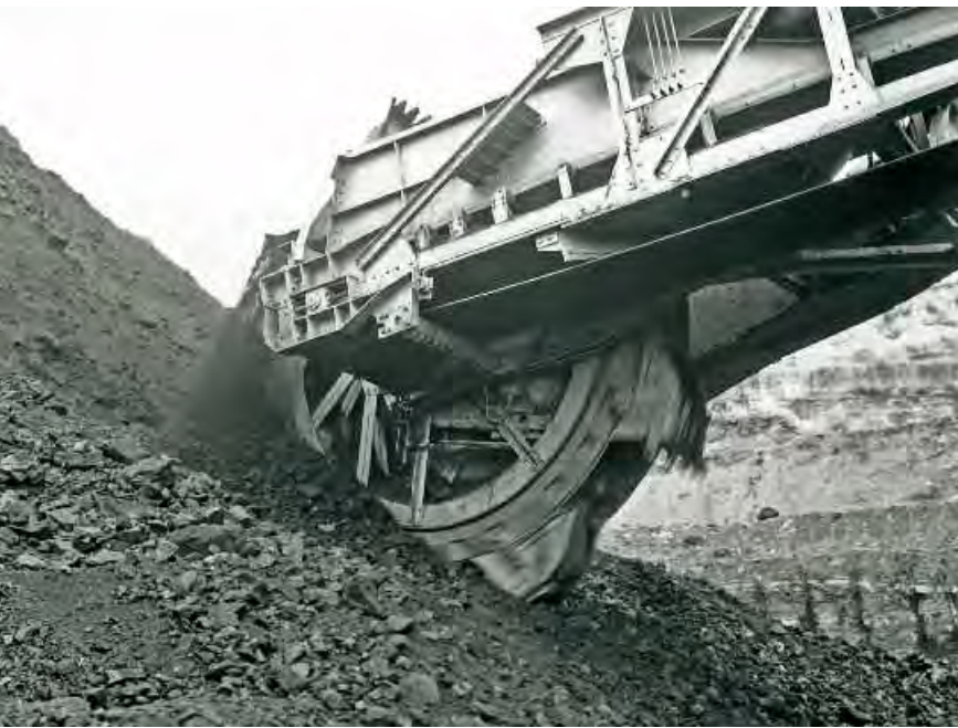
Detalle de la excavadora R1 ó R2
