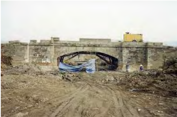
Traslado de “Ponte da Pedra” al Canal IV, 1992
