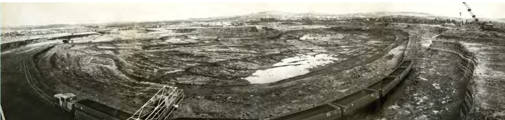
Vista general de la corta nª 2
