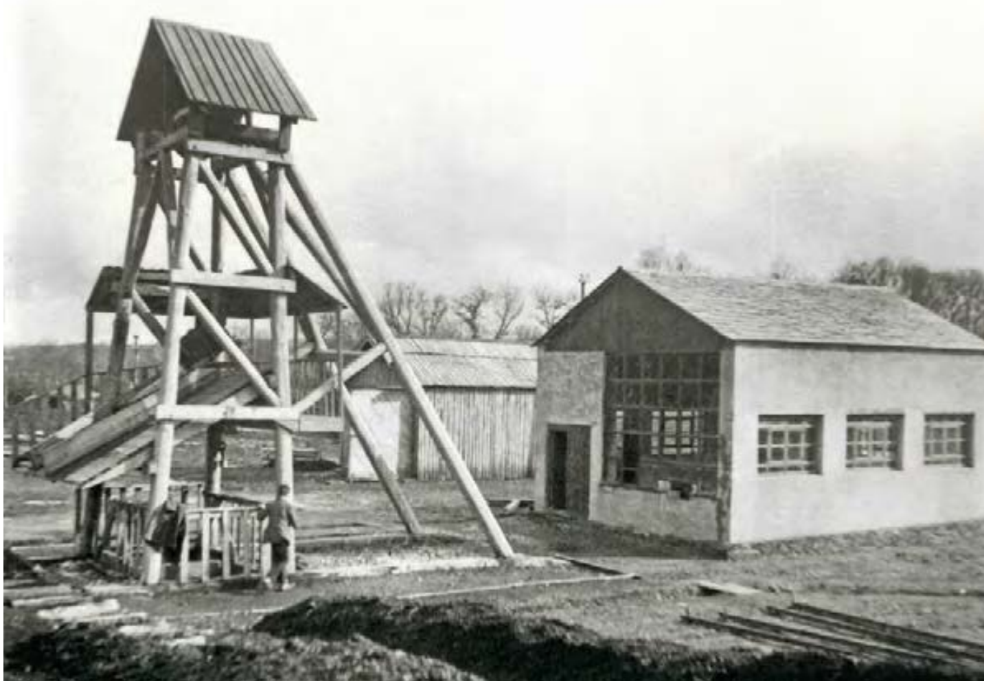
“Pozo grande”, castillete del sondeo de captación de 58m de profundidad
