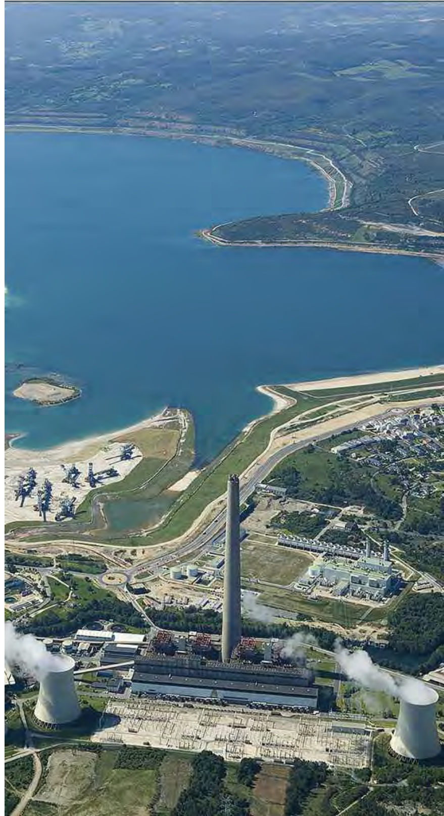
Situación actual utilizando carbón de importación, obsérvese la disminución de las emisiones en la chimenea
