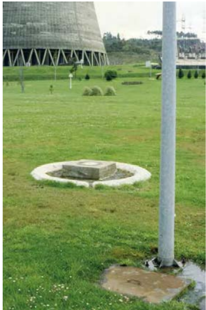
Hito topográfico instalado en la central térmica
