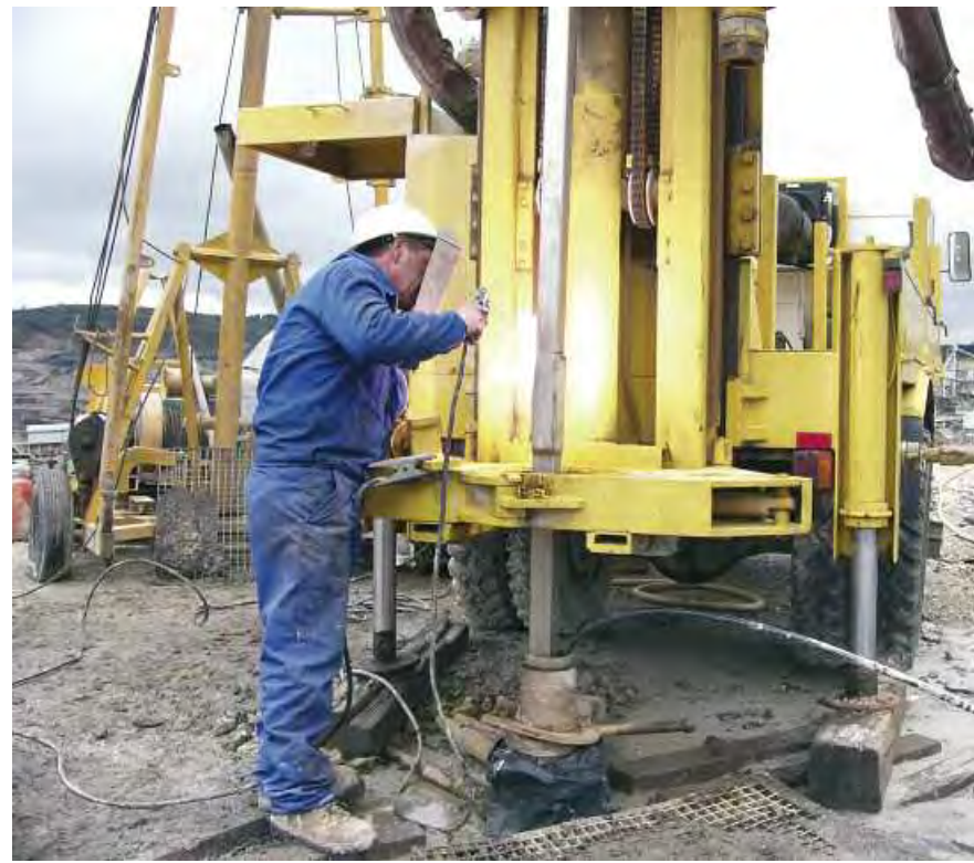
Instalación de inclinómetros
