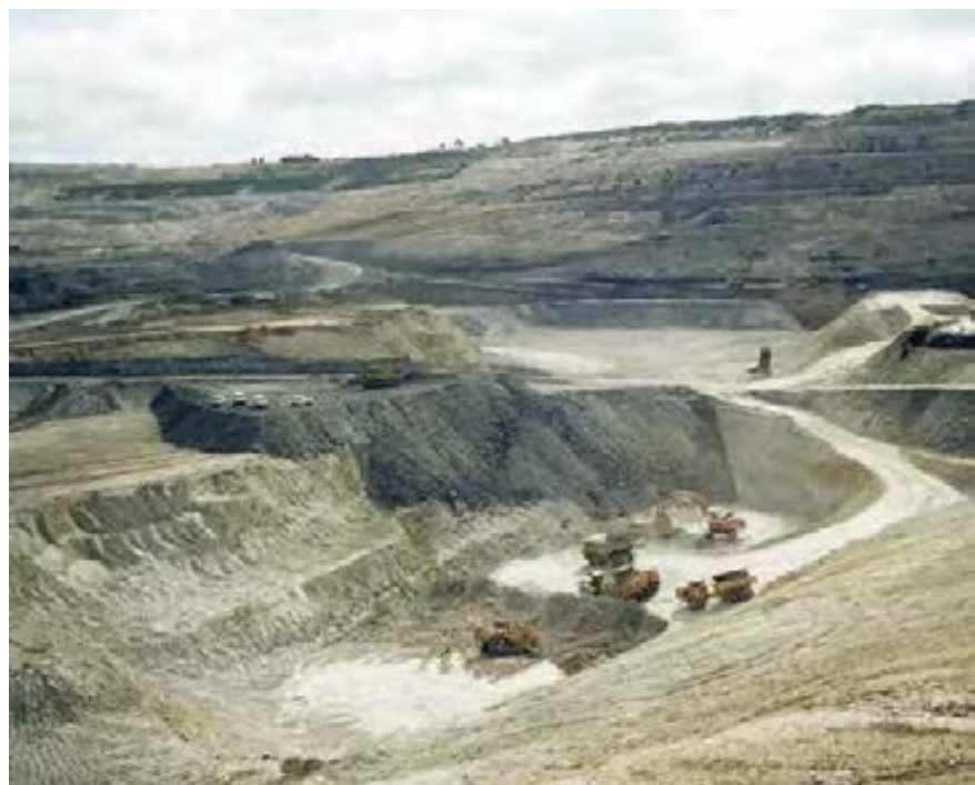
Excavación de apoyo de dique
