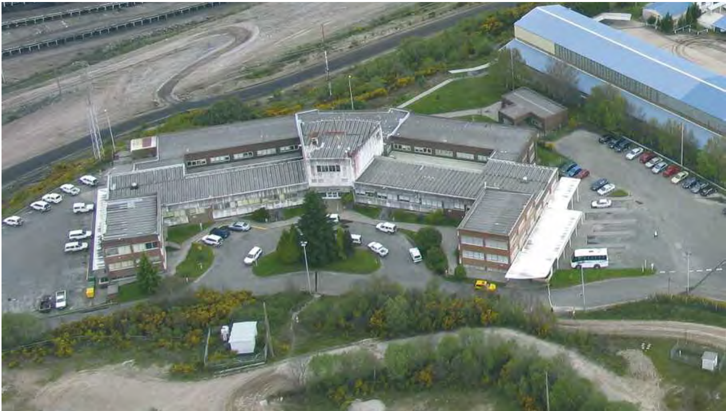
Vista aérea del edificio
