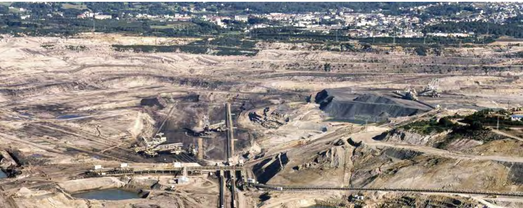
Vista general del campo este, simultaneando excavación y apilado
