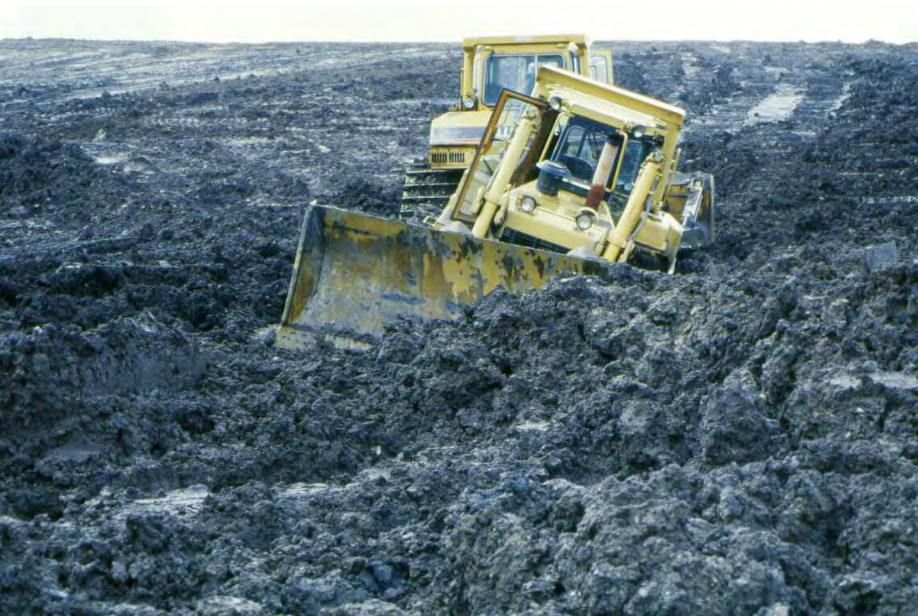
Las arcillas carbonosas son muy problemáticas, tanto en la restauración como en su manejo. Bulldozer con problemas, 2000
