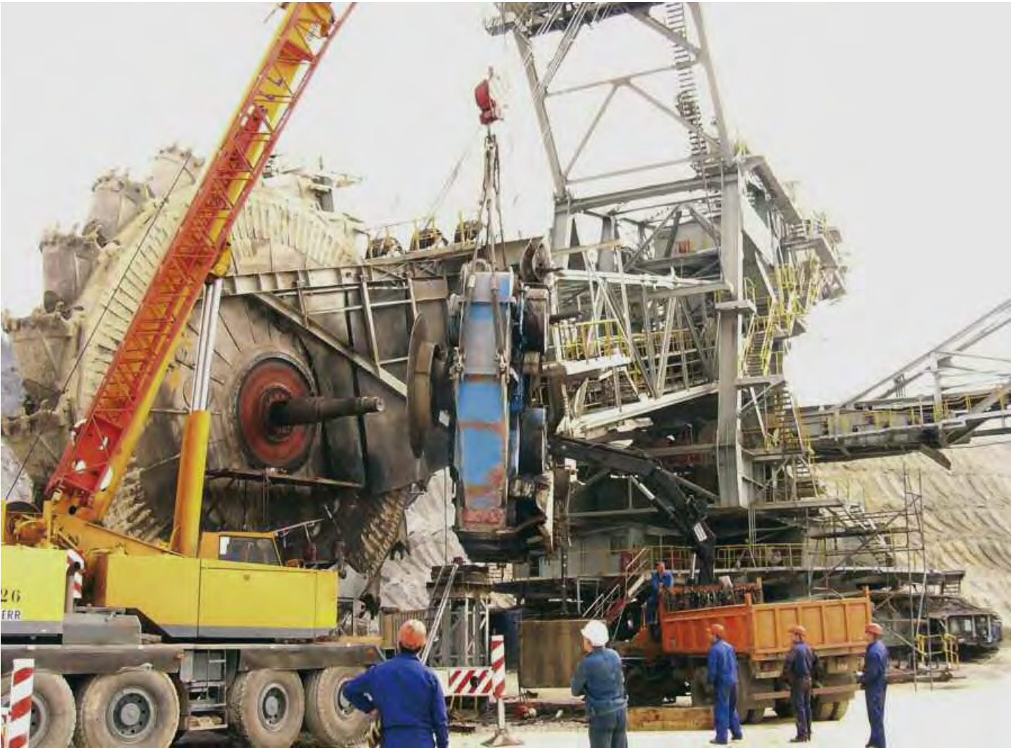
Cambio de reductora de rodete
