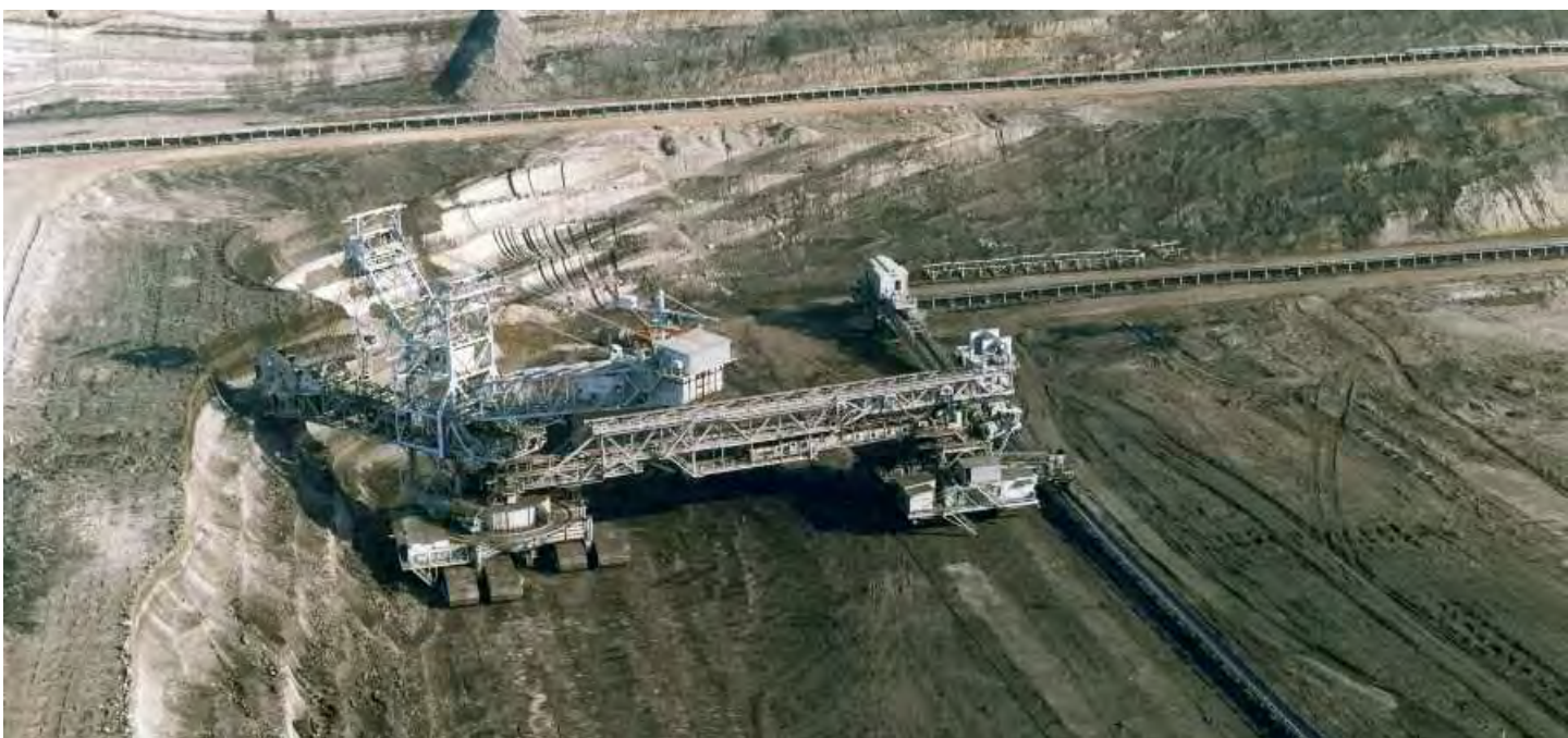
Excavadora en un banco en altura
