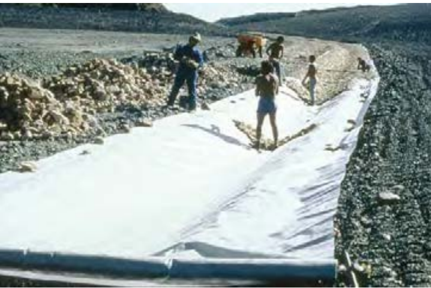
Inicialmente para la ejecución de las cunetas se utilizaba un geotextil impermeable que se demostró que era contraproducente, 1988
