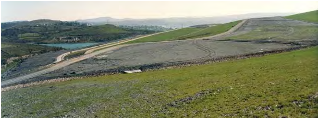
El mismo sector en fase de restauración, 1989
