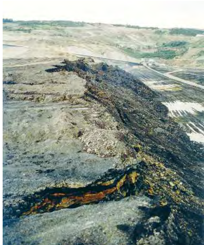
Grietas en borde talud del sector 500, 1990
