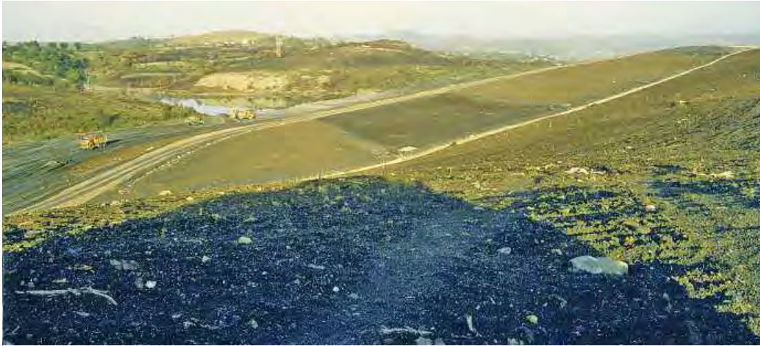
Sector de la escombrera en fase de construcción. El lago Braña al fondo, 1988
