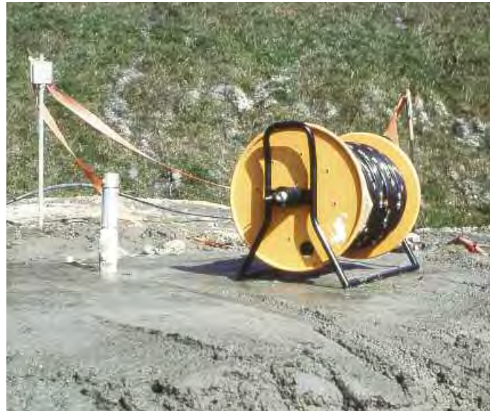
Inclinómetro y carrete del cable de medida
