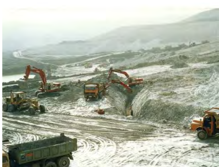
Instalación de drenes horizontales en el fondo de la escombrera-R
