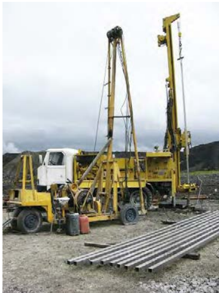
Instalación de un inclinómetro, 1992
