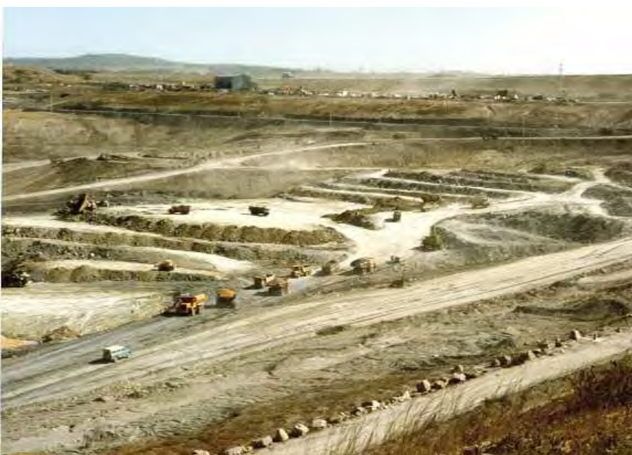
Preparación apoyo escombrera-R
