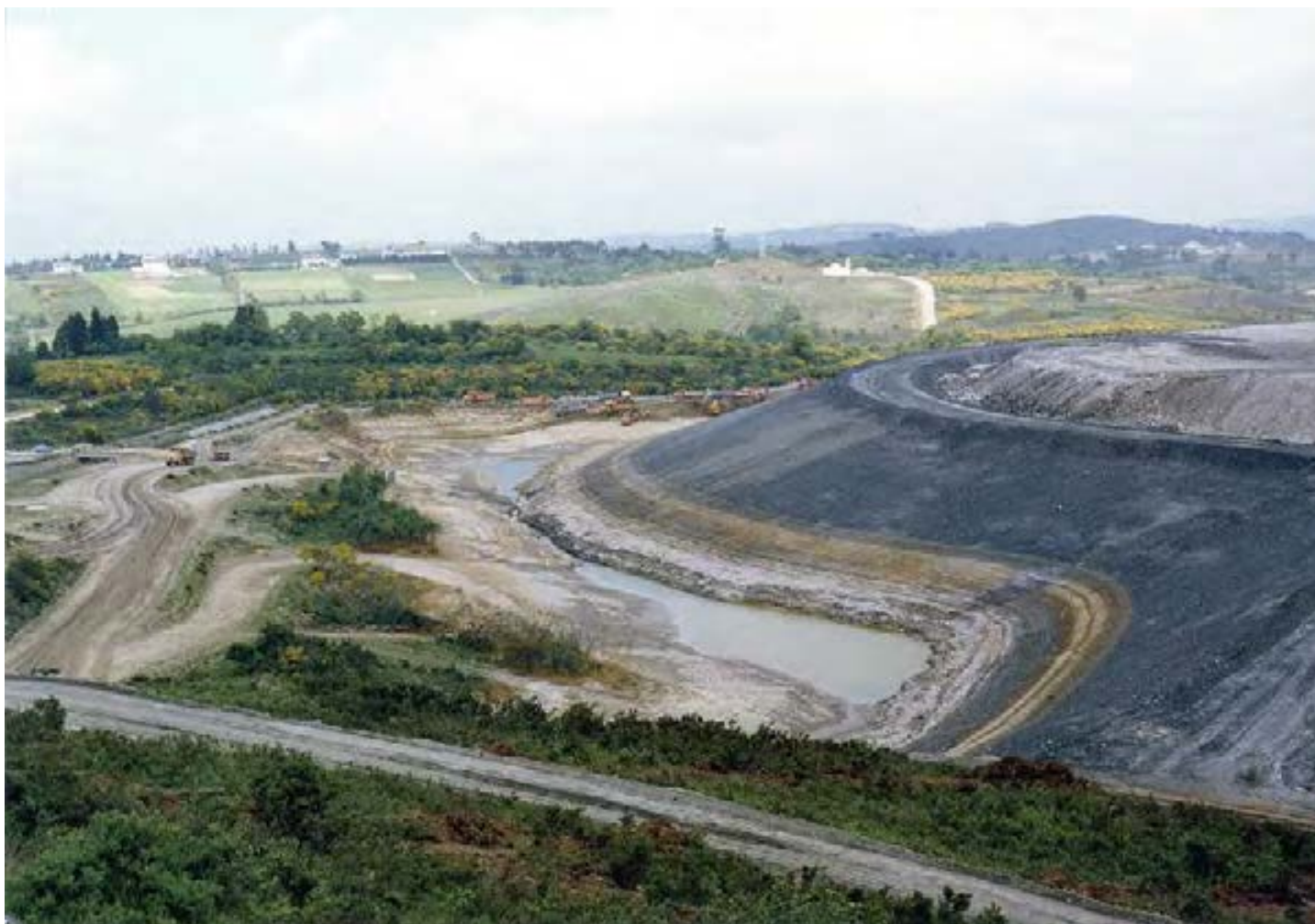
Escombrera F en ejecución, 1987
