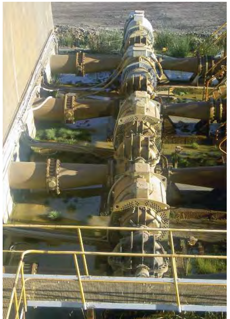
Bombas en el deposito II-EB
