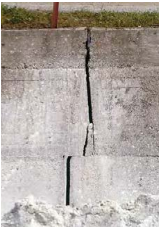
Grieta canal de guarda, 1983
