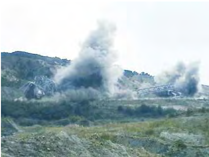
Secuencias de la voladura previa al achatarramiento de la excavadora E-14 y la apiladora A-27. Esta operación ahorra los costes de desmontaje
