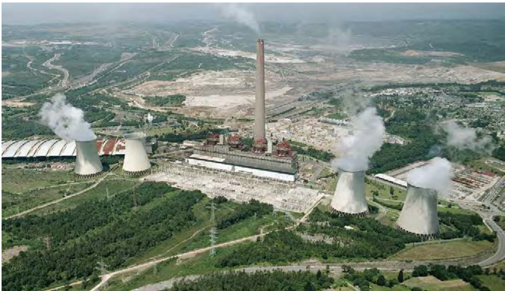
Vista general de la central térmica con la mina al fondo, 2007
