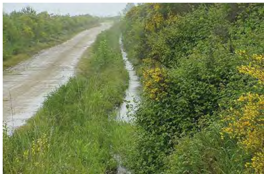
En poco tiempo este tipo de cunetas, ya sin geotextil, quedan ocultas por la vegetación, 1991 y 1999
