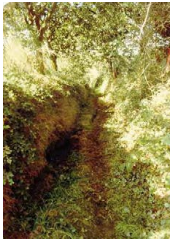
Grieta que originó un desnivel en el camino de Portoferreiro, 1983
