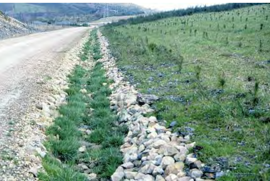
En poco tiempo este tipo de cunetas, ya sin geotextil, quedan ocultas por la vegetación, 1991 y 1999
