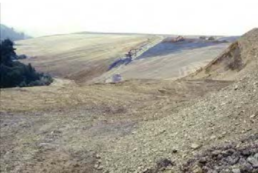
El mismo talud tratado con pizarras del umbral, 1992 y 1993
