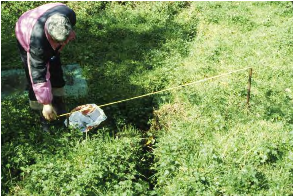
Primera grieta detectada, 1983
