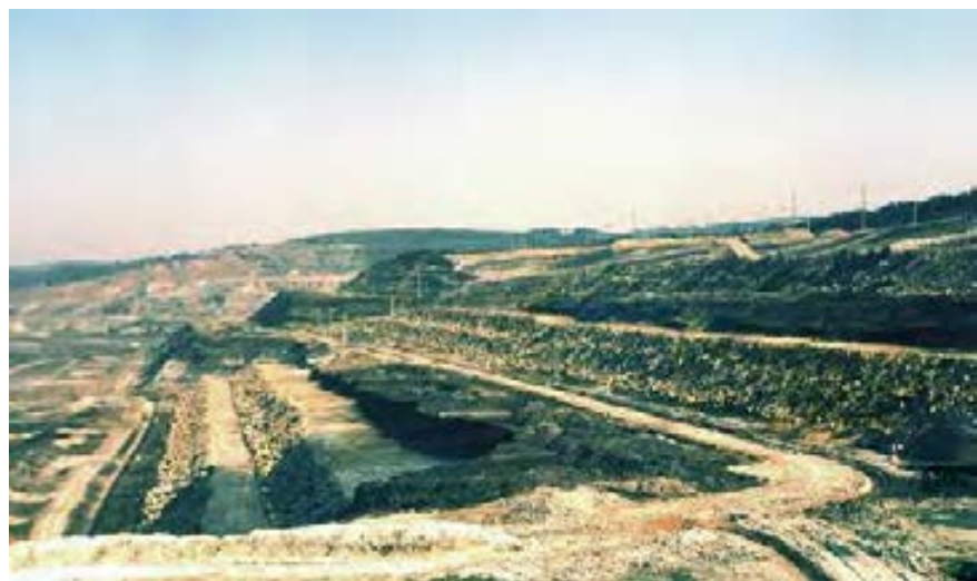
Diques de contención de los tres primeros bancos en la zona de Enfersa. Al fondo, taludes sin protección en el área de La Casilla
