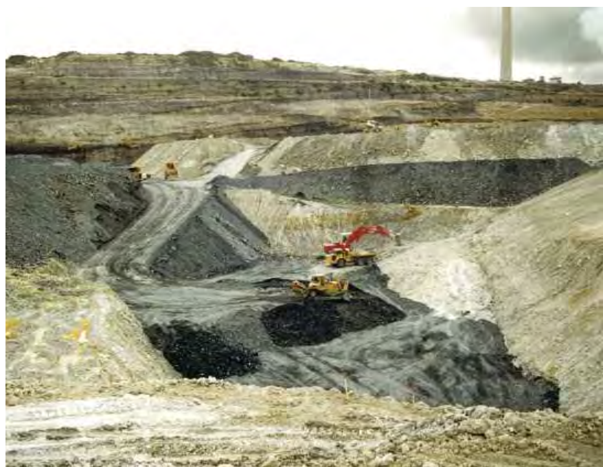
Inicio del relleno
