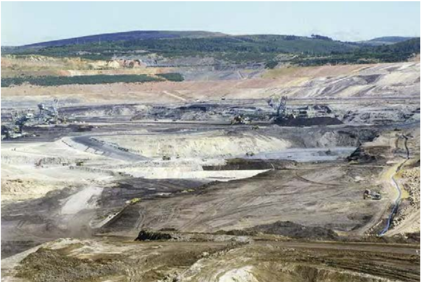
Apiladoras A-25 y A-29 desarrollando la escombrera interior
