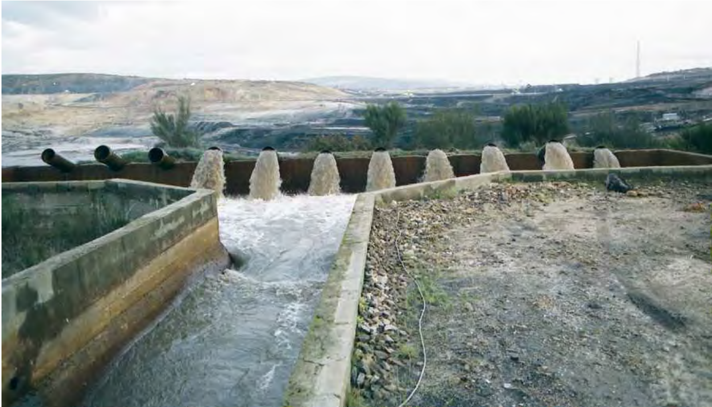
Bombeo del depósito OB-5 al OB-4
