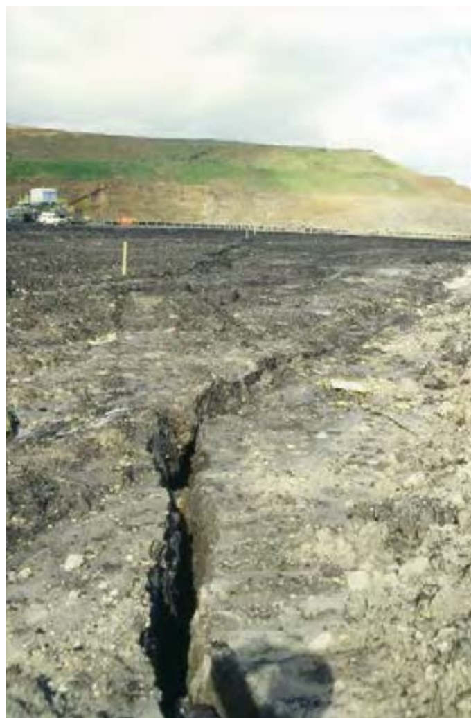
Grieta en el sector 500, 1989
