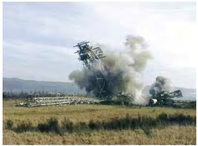
Secuencias de la voladura previa al achatarramiento de la excavadora E-14 y la apiladora A-27. Esta operación ahorra los costes de desmontaje
