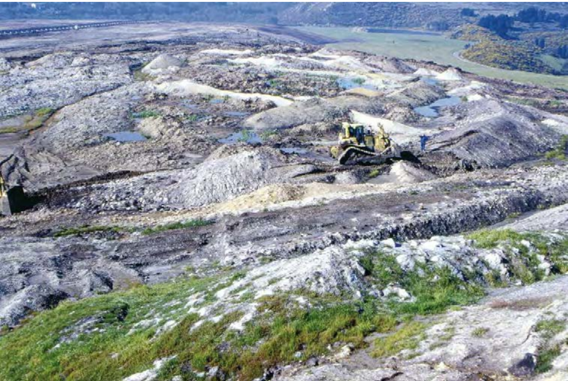
La geometría de los niveles se consigue a base de maquinaria pesada, 2001
