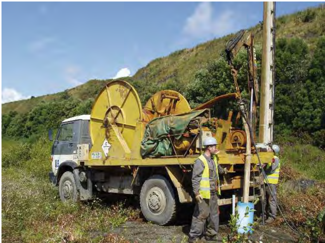
Montaje de bombas en sondeos
