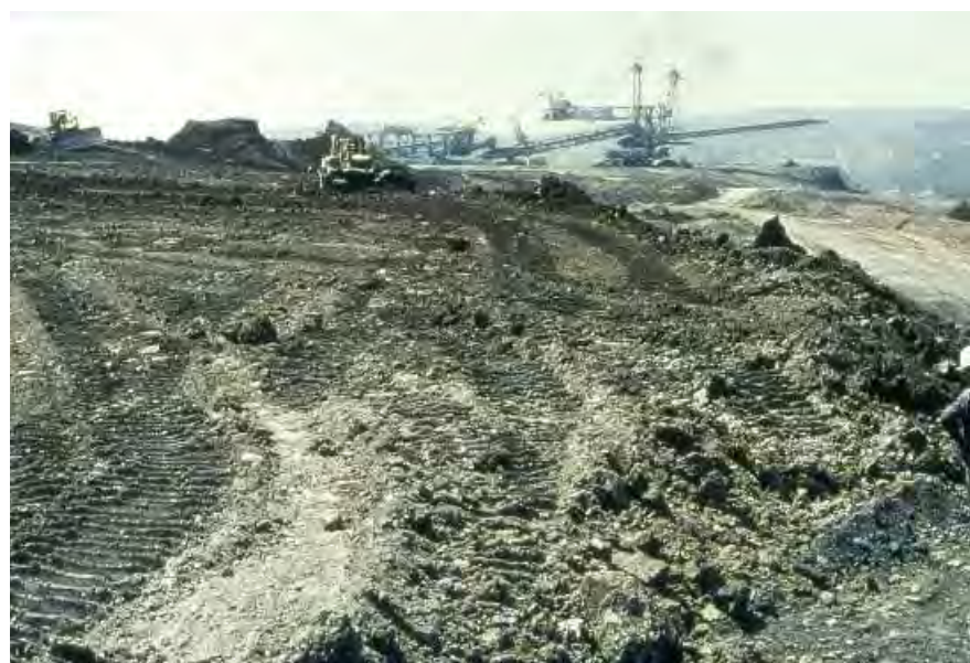
La preparación de las superficies aumenta la compactación de los materiales, 1990
