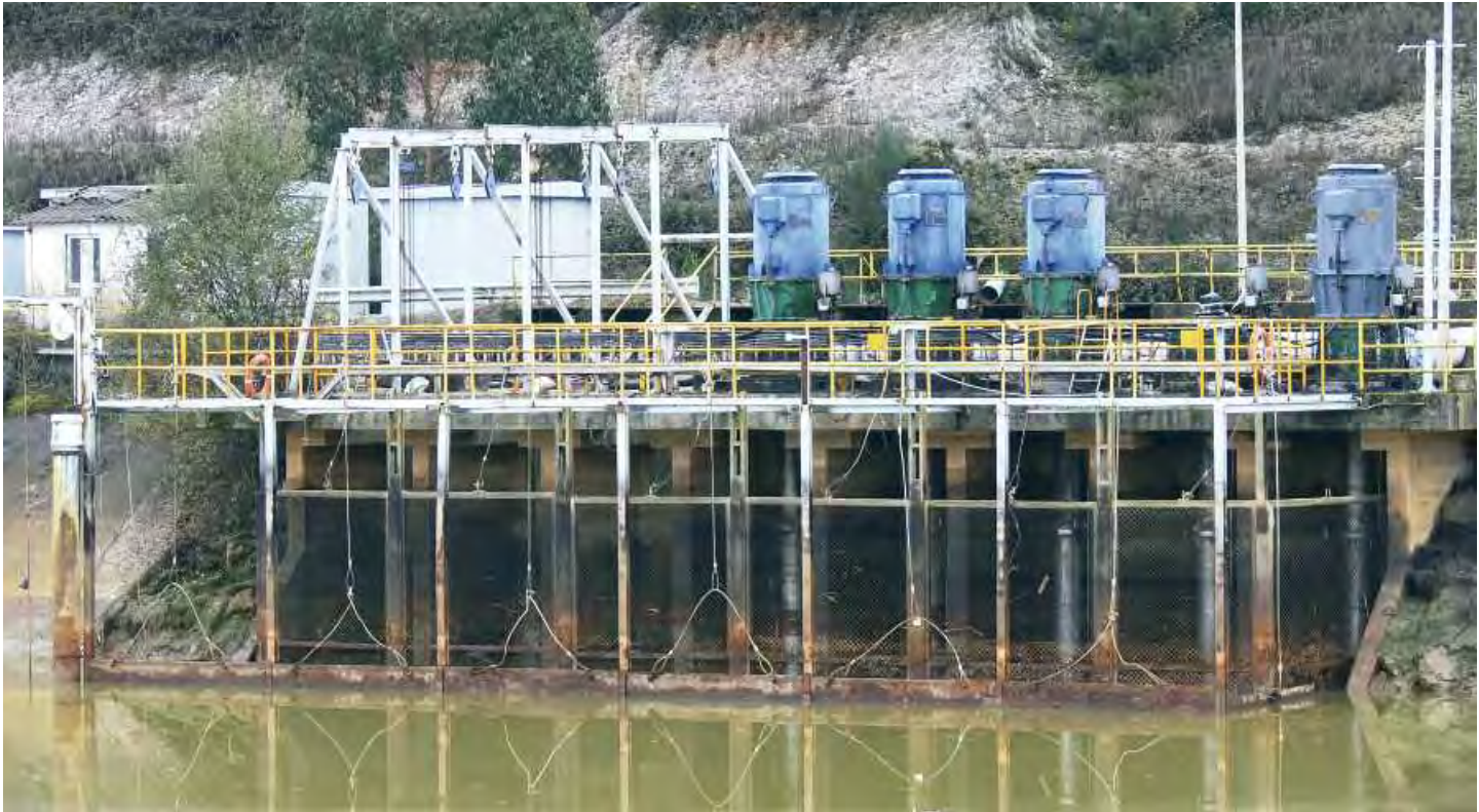
Depósito OB-4, con sus bombas Worthington
