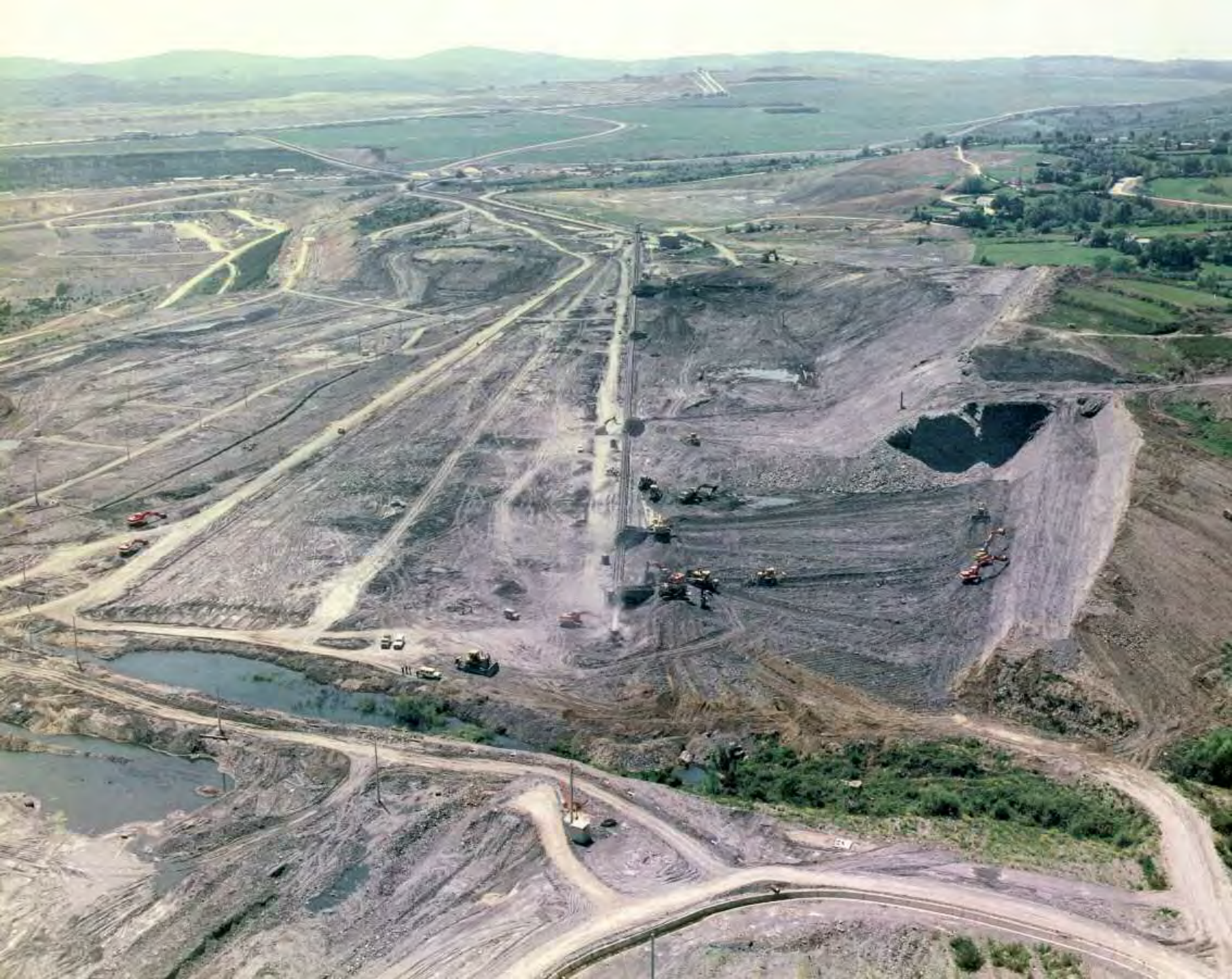
Excavación de pizarras en el talud norte con medios contratados
