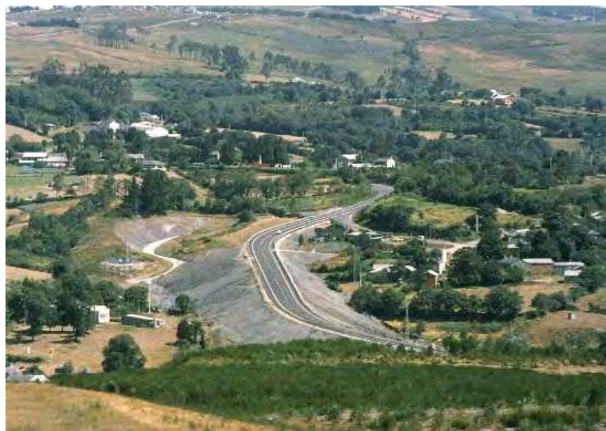
Desvío de la carretera de Espiñaredo, 1989
