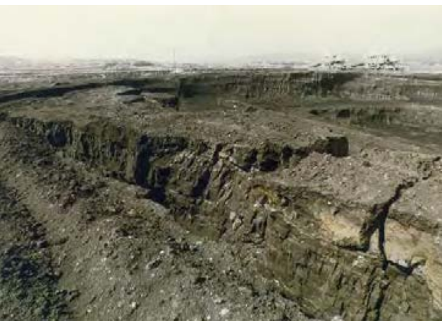
Deslizamiento en el primer banco, 1977
