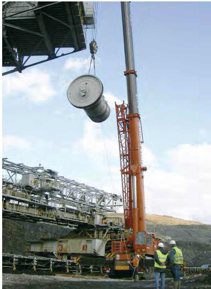
Cambio de cabrestante de izado
