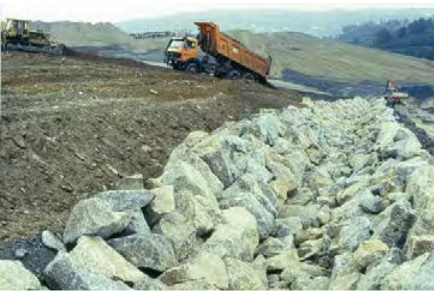
Ejecución de una cuneta en un talud del nivel inferior de la vertiente oeste para conducir las aguas hacia el canal perimetral, 1992
