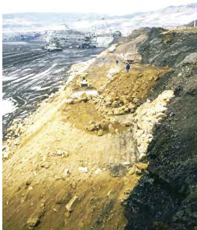
Dique de contención del tercer banco en zona de Enfersa
