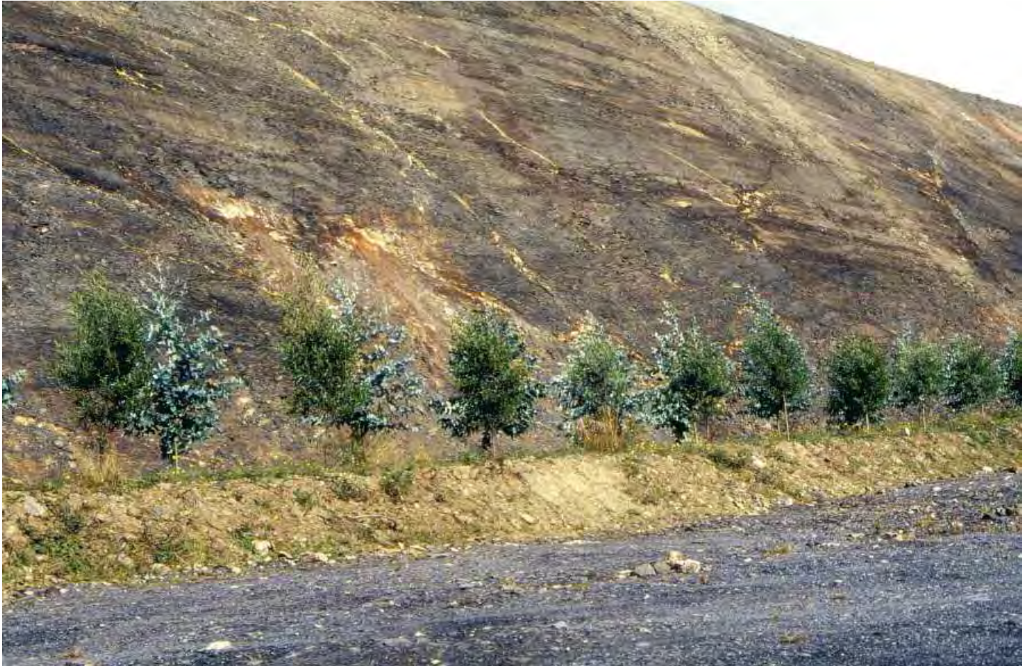
Talud de pizarras con el color característico que origina la oxidación de la pirita, 1997
