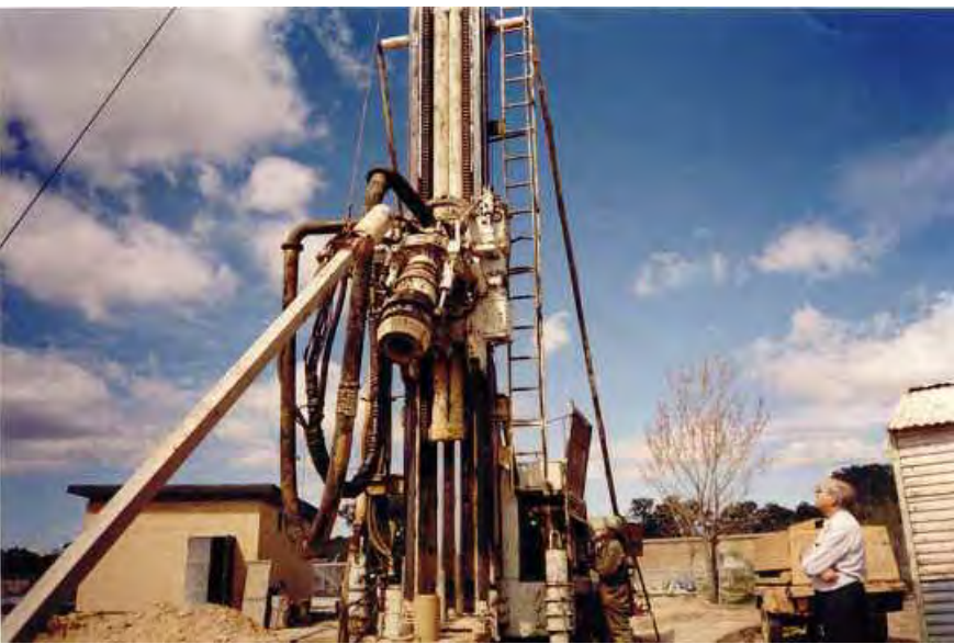
Sonda realizando una perforación, 1990
