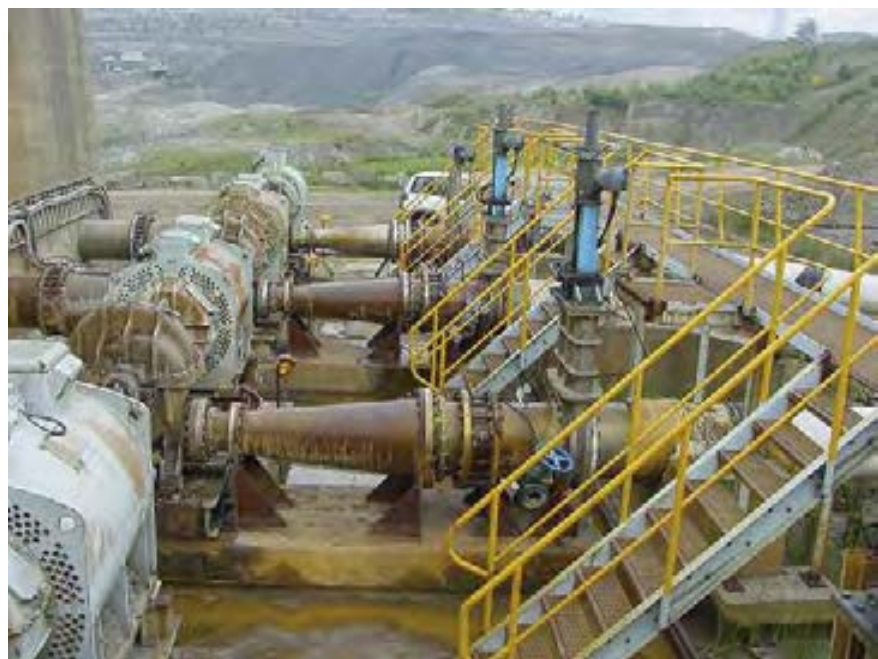
Equipo de bombeo del depósito II-EB
