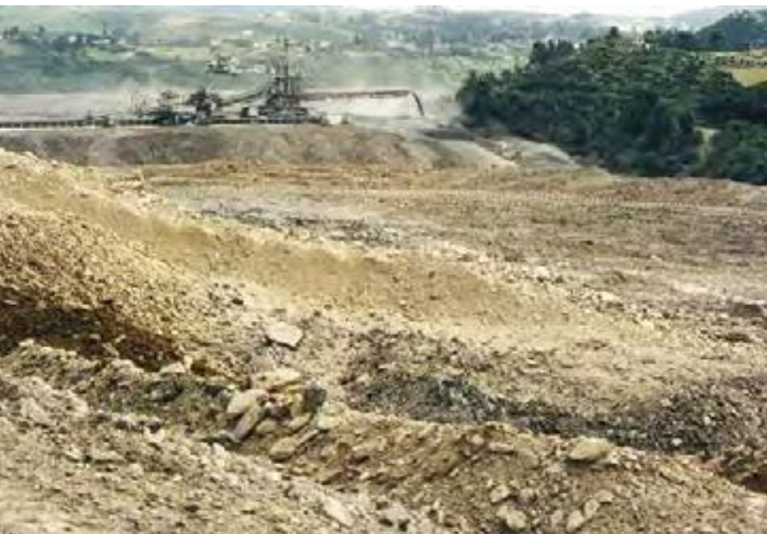
Apiladora trabajando en el sector oeste, 1995
