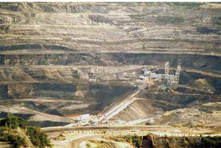
Escombrera interior intermedia, dique contención de pizarra ejecutado con medios auxiliares
