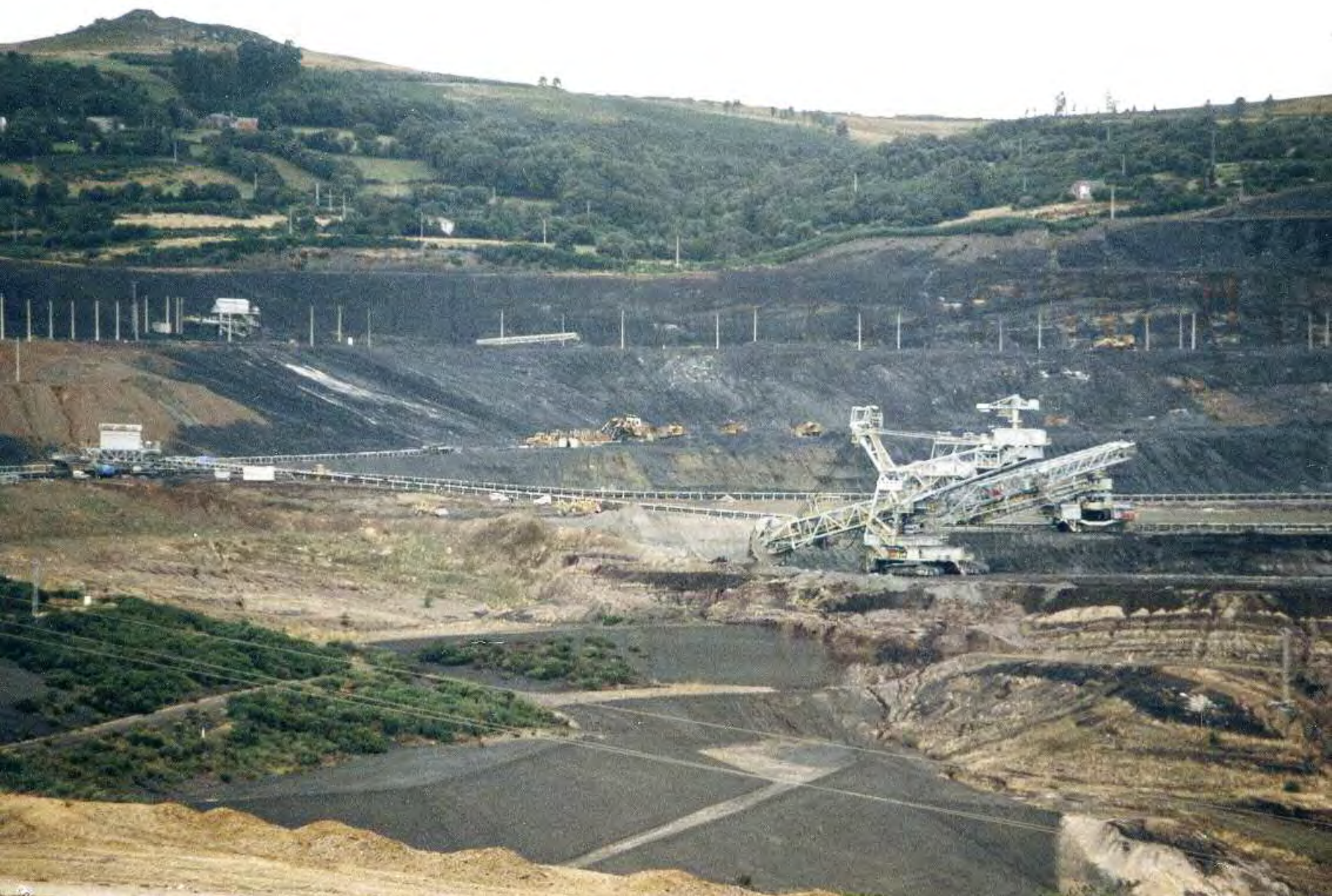
Excavación de pizarras en el talud oeste, en primer término la escombrera R
