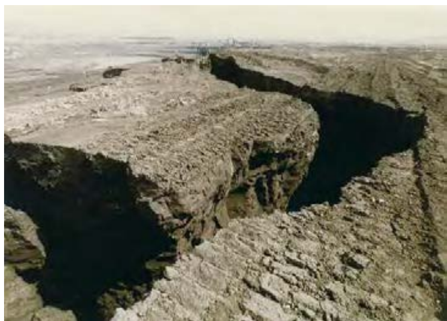
Deslizamiento en el primer banco, 1977
