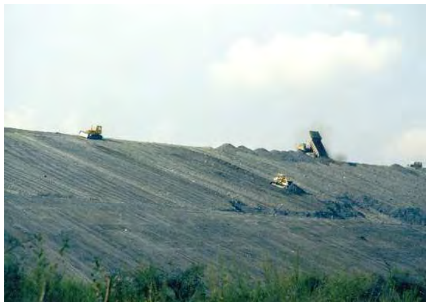
En ocasiones, la construcción de la escombrera ha sido apoyada por medios auxiliares. Formación de un talud con pizarras procedentes de Espiñaredo-1988
