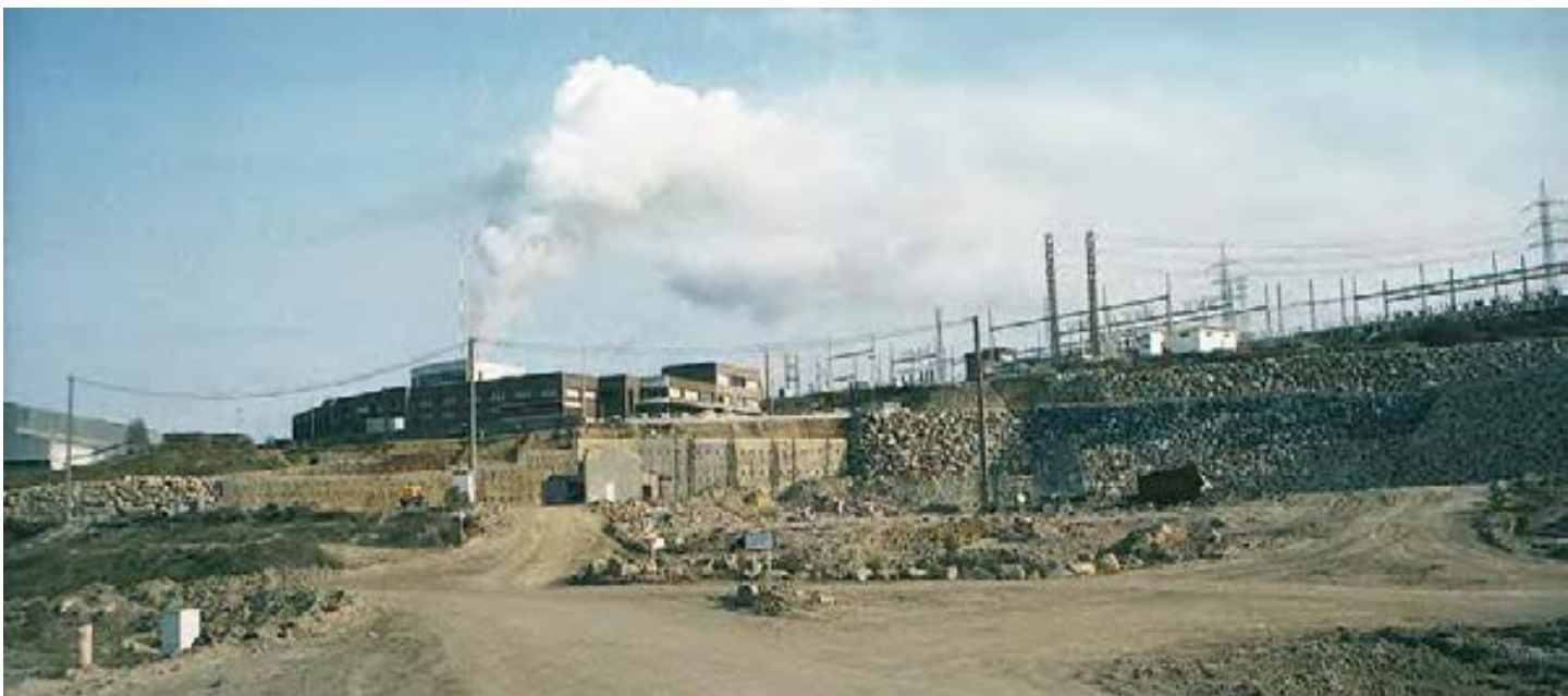
Diversas fases de la ejecución del muro pantalla, 1991
