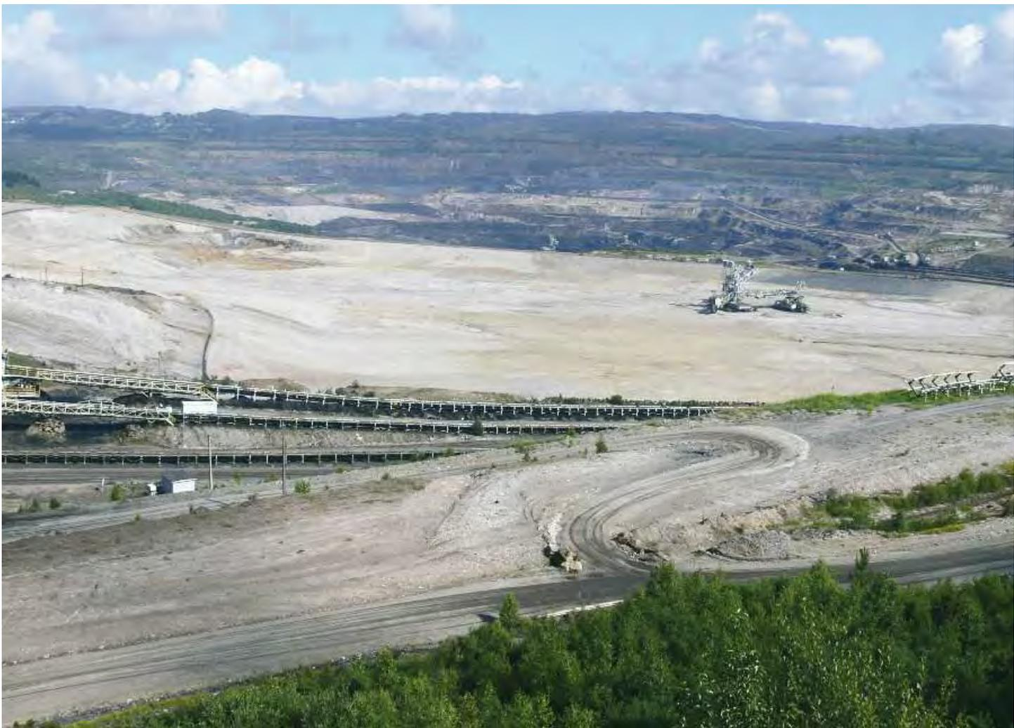
Una medida preventiva de gran importancia, que se encuentra en fase de implantación es la restauración de los taludes emergentes de la mina. De la experiencia obtenida de la restauración de la escombrera exterior se puede asegurar que la implantación de una cubierta vegetal permanente en las superficies mejora la calidad de las aguas de escorrentía y, por tanto, su aportación al lago.
