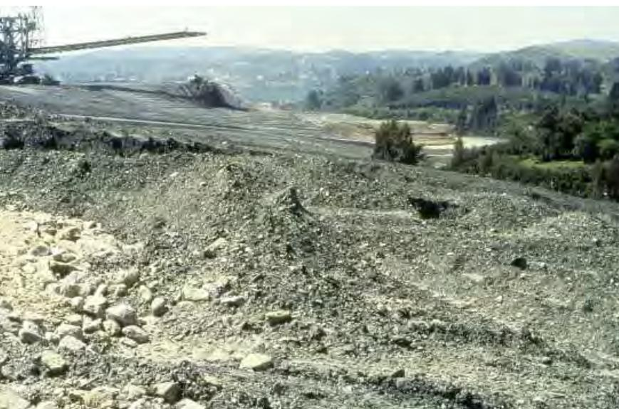
Superficie tratada con estériles seleccionados. Preparación del talud inferior de la vertiente oeste. Monte Forgoselo a la derecha, 1992
