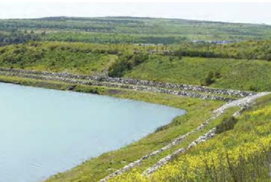
La colocación de mantos de escollera a lo largo del perímetro del lago evitará la erosión de los taludes, con lo que asegurará su estabilidad. Tanto en el diseño de estas protecciones como en el de la playa se consideró el régimen de vientos imperante.
