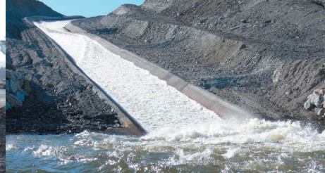
Desagüe del canal Este
