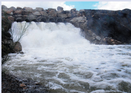
Descarga del Sector 500 al Campo Oeste, octubre 2009
