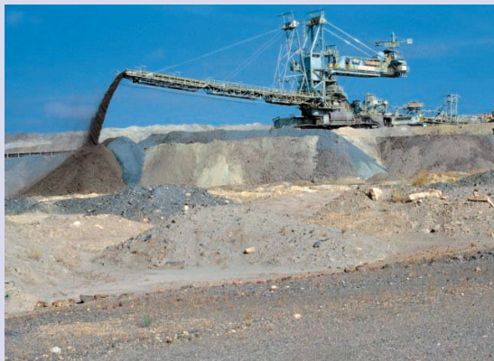
Apiladora en la Excombrera Exterior
