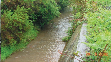
Canal perimetral de la escombrera
