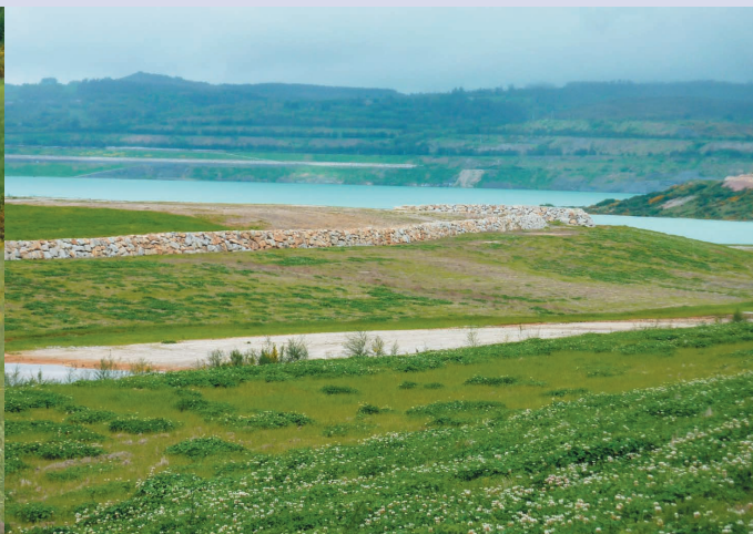
Escollera de protección de un escalón
