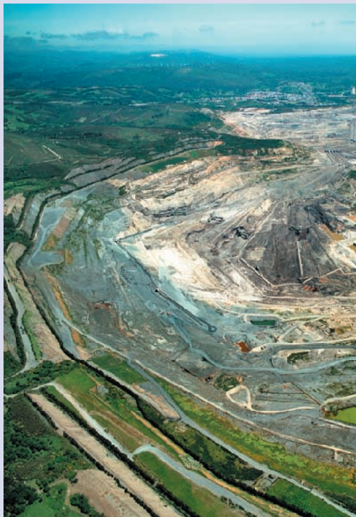
Vista general de la Mina al final de la explotación
