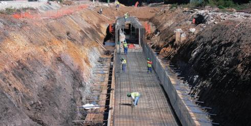
Construcción del canal Este de Llenado
