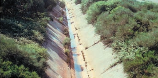
Canal Sur de mina
