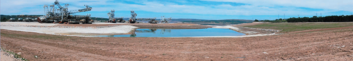
Desagüe antes de restaurar las márgenes, octubre 2009
