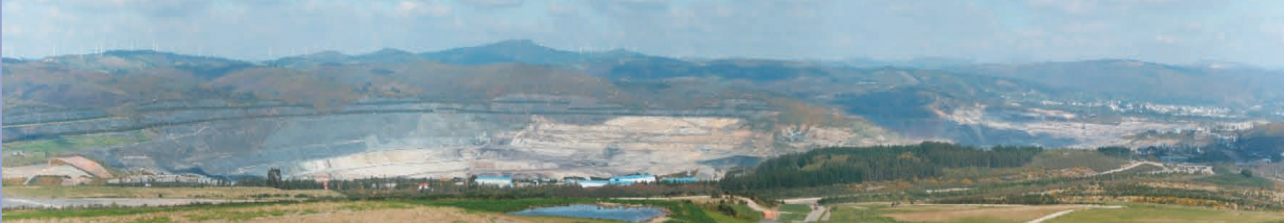
Vista general de la Mina, diciembre 2007
