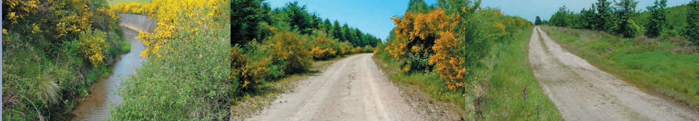
Canal perimetral de la Escombrera
