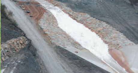
Canal Oeste de llenado
