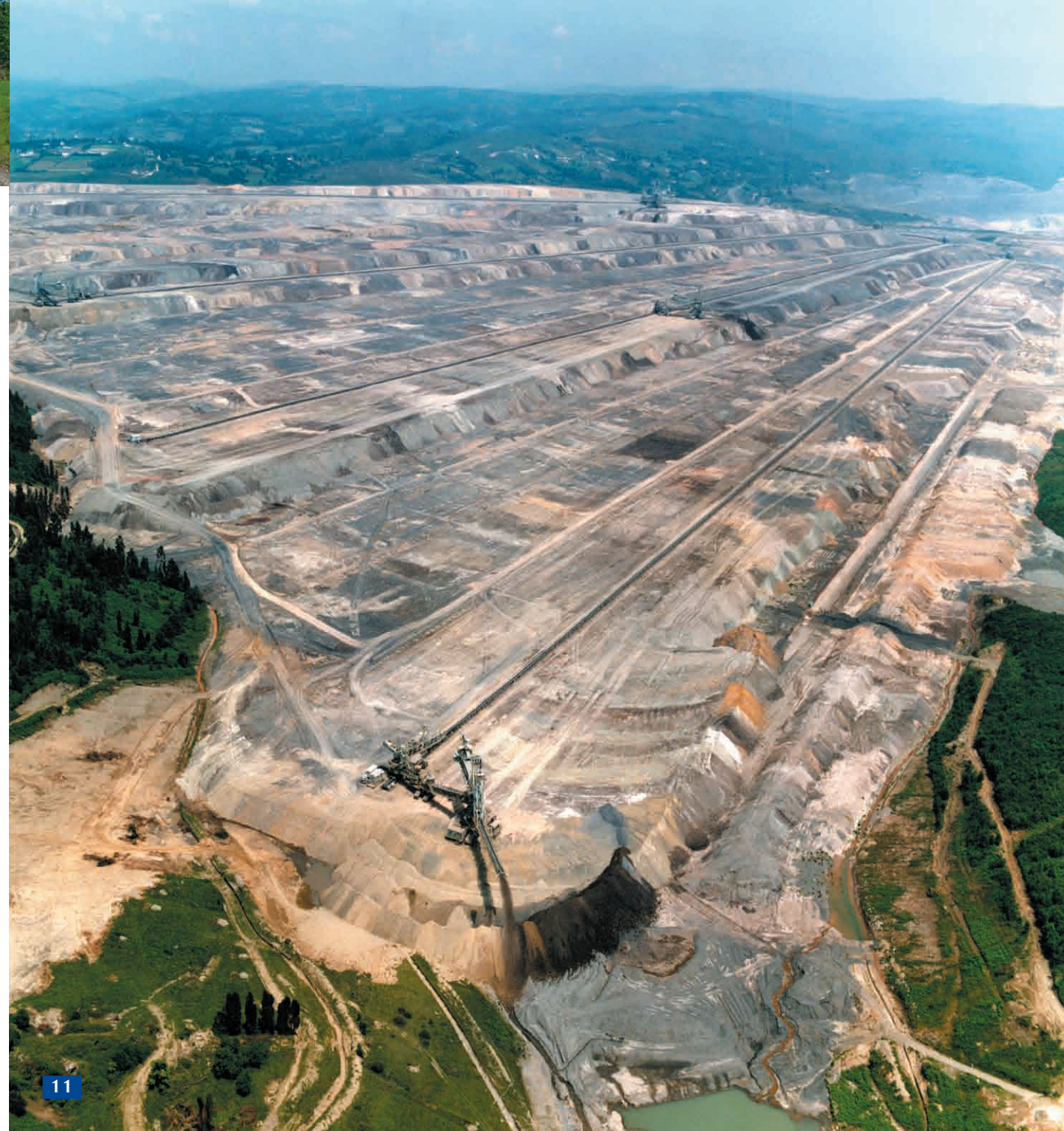
Escombrera Exterior en ejecución, 1992
