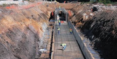
Construcción del canal Este de llenado
