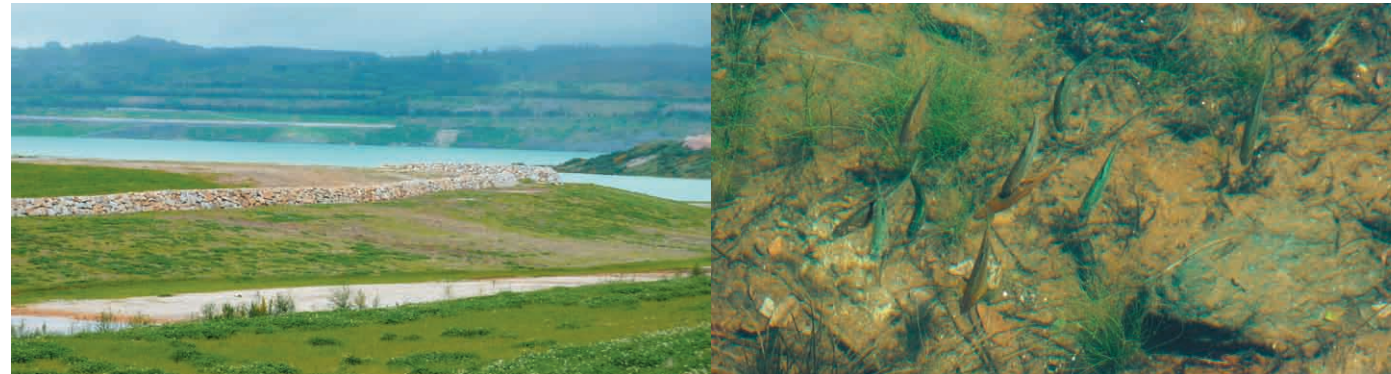
Escollera de un nivel
