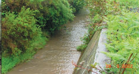
Canal perimetral de la escombrera
