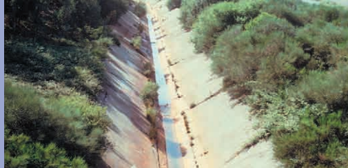
Canal Sur de mina
