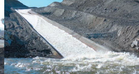
Desagüe del canal Este
